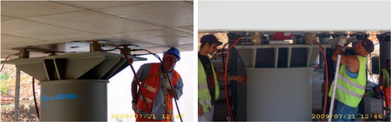
Fig. 24. Posa indiretta di dispositivi di isolamento: sollevamento (a) con martinetti idraulici e posa (b) del dispositivo con piastre di spessorazione.
