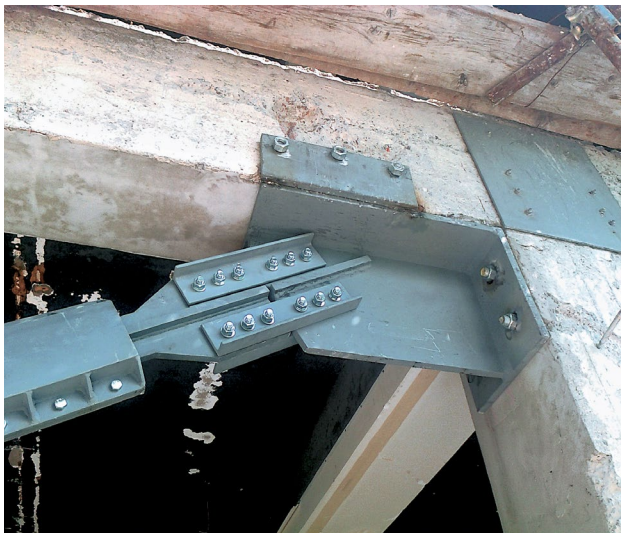
Figura 22b Controventi BRB: dettagli (realizzazione).
