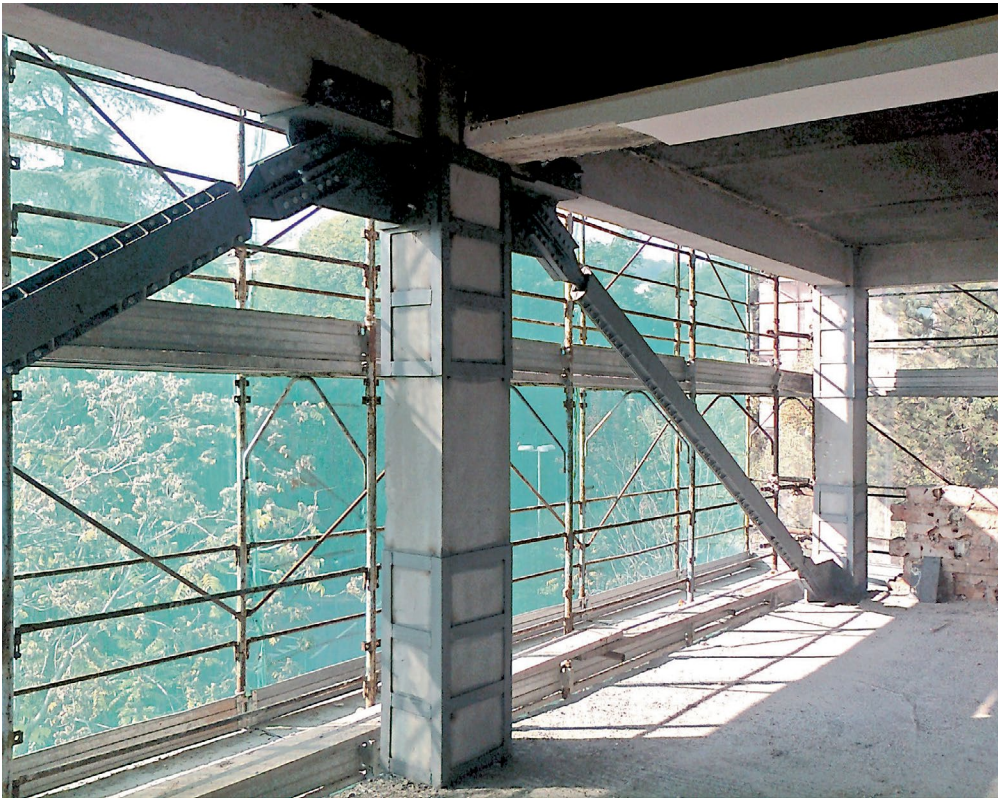
Figura 17b Rinforzi alle estremità dei pilastri (realizzazione).
