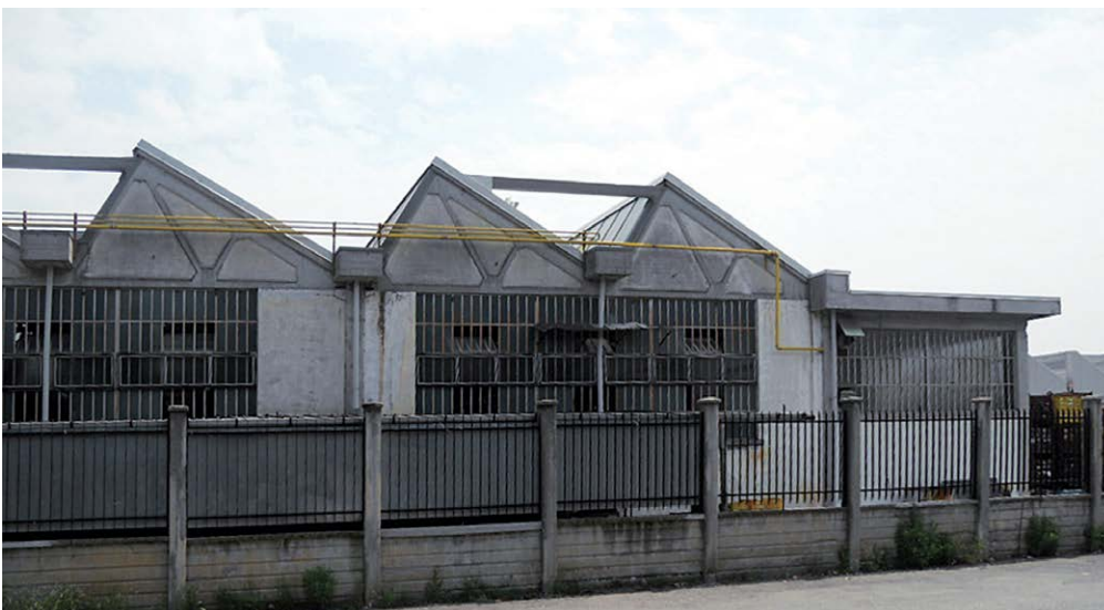
Figura 3 Facciata ovest dei Capannoni 2 e 3.
