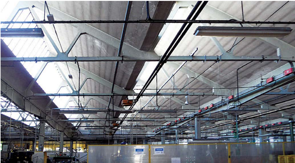
Figura 2 Travi di copertura a "shed" del Capannone 1.
