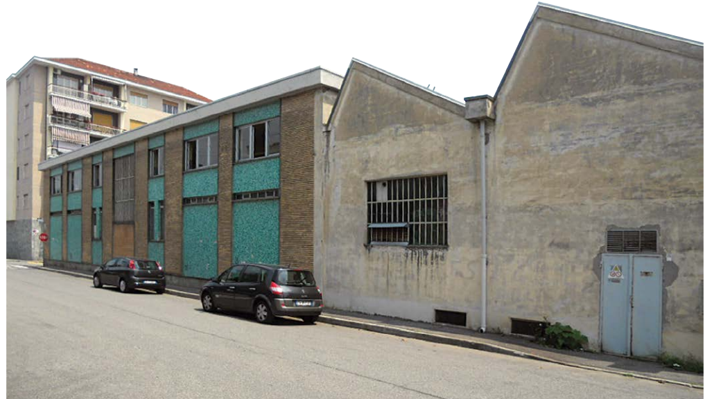
Figura 5 Facciata ovest del Fabbricato B e del Capannone 1.
