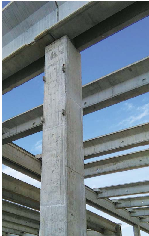
Figura 20 Edificio 2_Pilastro cerchiato per adeguamento sismico.
