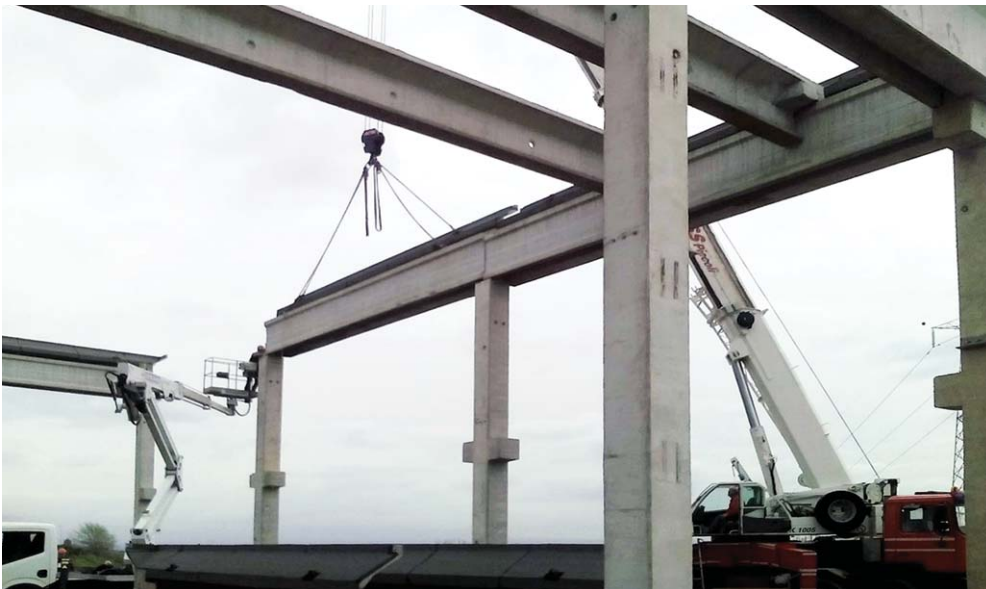
Figura 14 Edificio 1_Movimentazione e montaggio travi e tegoli di copertura.
