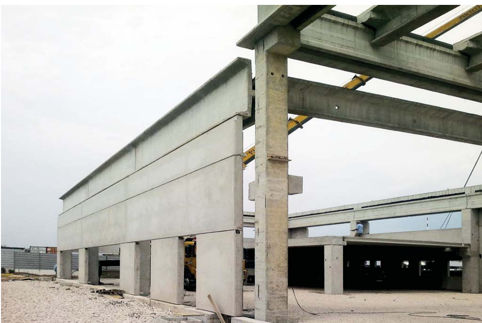
Figura 15 Edificio 2_Montaggio struttura e tamponatura in pannelli prefabbricati.
