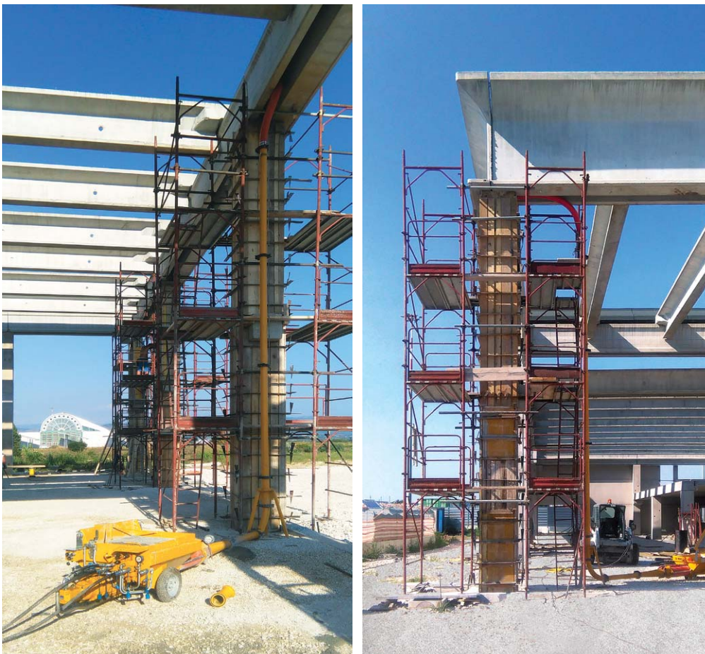
Figura 19 Edificio 2_Armatura della cerchiatura su pilastri per adeguamento sismico.
