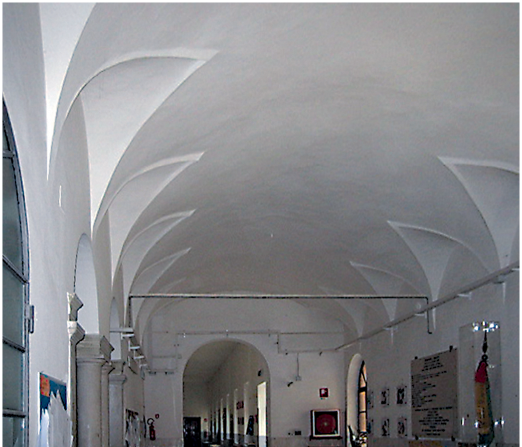
Figura 21 Vista interna della volta a botte lunettata.
