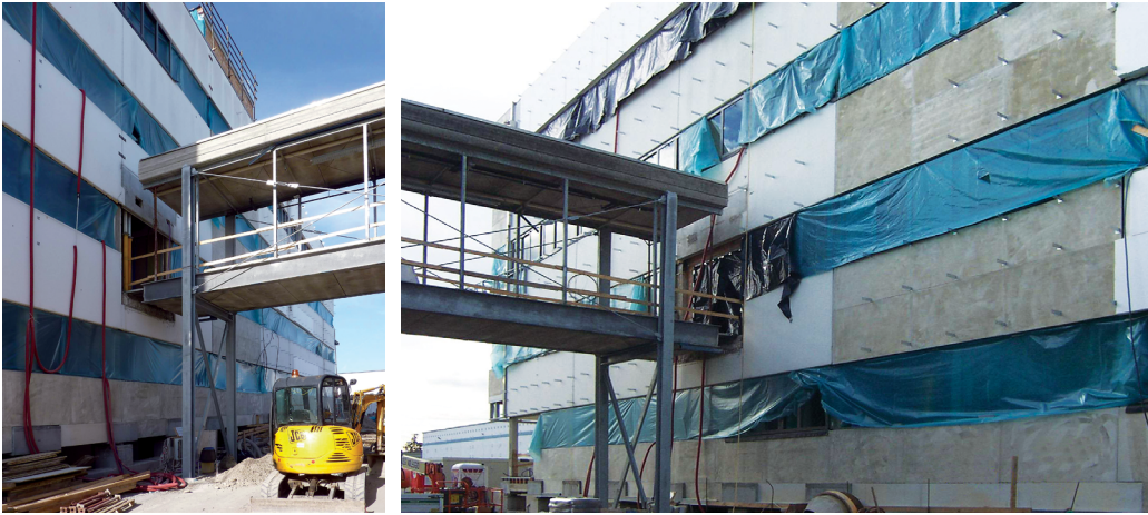
Figura 14 Consolidamento tunnel lato est e realizzazione giunto sismico.
