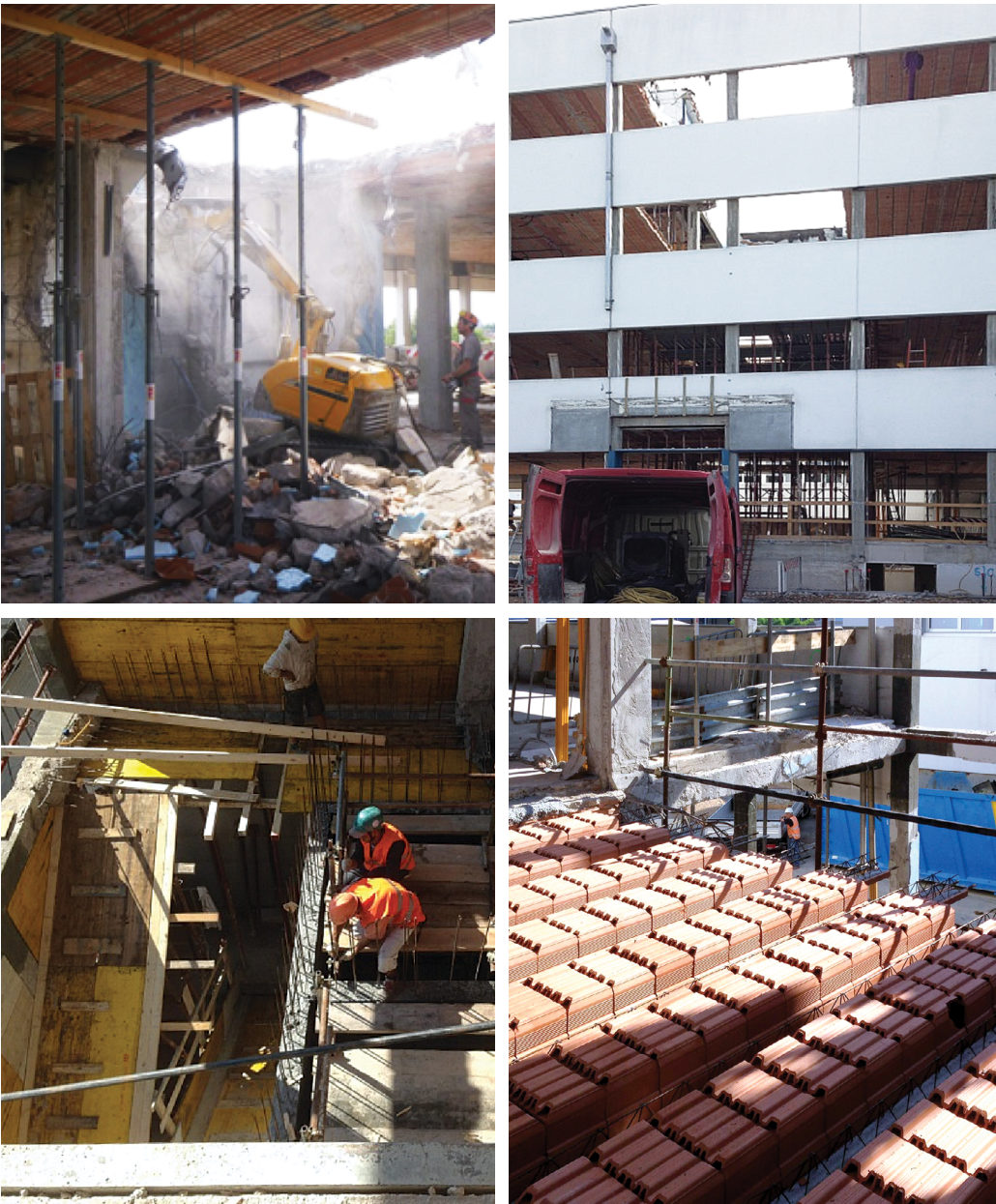
Figura 12 Demolizione e ricostruzione corpo scale-ascensore e campi di solaio lesionati.
