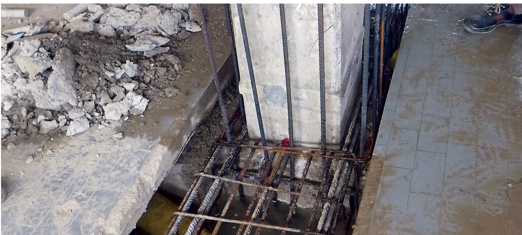
Figura 16 Esecuzione di nuovi cordoli di fondazione nella direzione ortogonale ai telai in conglomerato cementizio armato.
