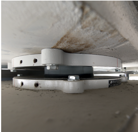
Figura 22: Esecuzione del getto di allettamento e inghisaggio dell'isolatore con l'utilizzo malta cementizia.
