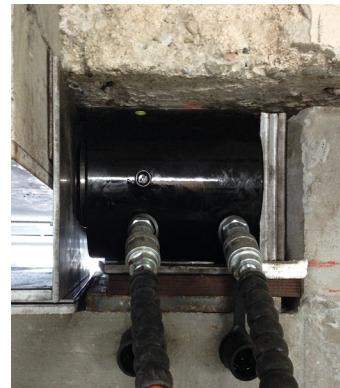
Figura 24 Prova di spinta dell'edificio, posizionamento martinetti idraulici e muri di contrasto.
