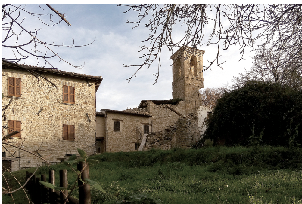
Figura 13 Figura 13 Immediatamente visibile il positivo effetto delle catene sul fabbricato di sinistra: gli interventi eseguiti ne hanno scongiurato il crollo. Le catene sono state posizionate fino sotto alla quota di gronda (in basso).
