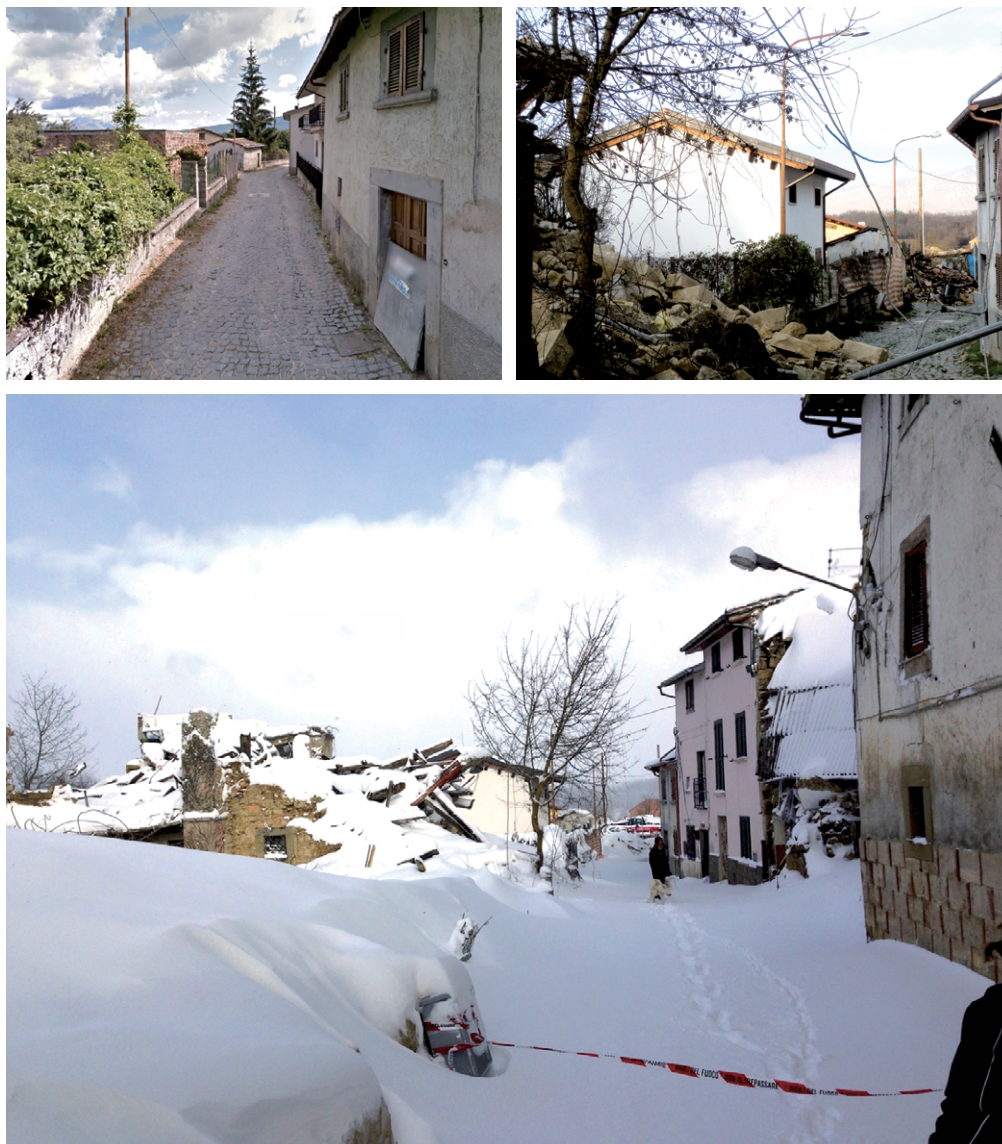
Figura 31 Foto Edificio 8 di pre sisma (2011) mentre era in costruzione e post sisma in data 1/12/2016 e in data 17/1/2017.
