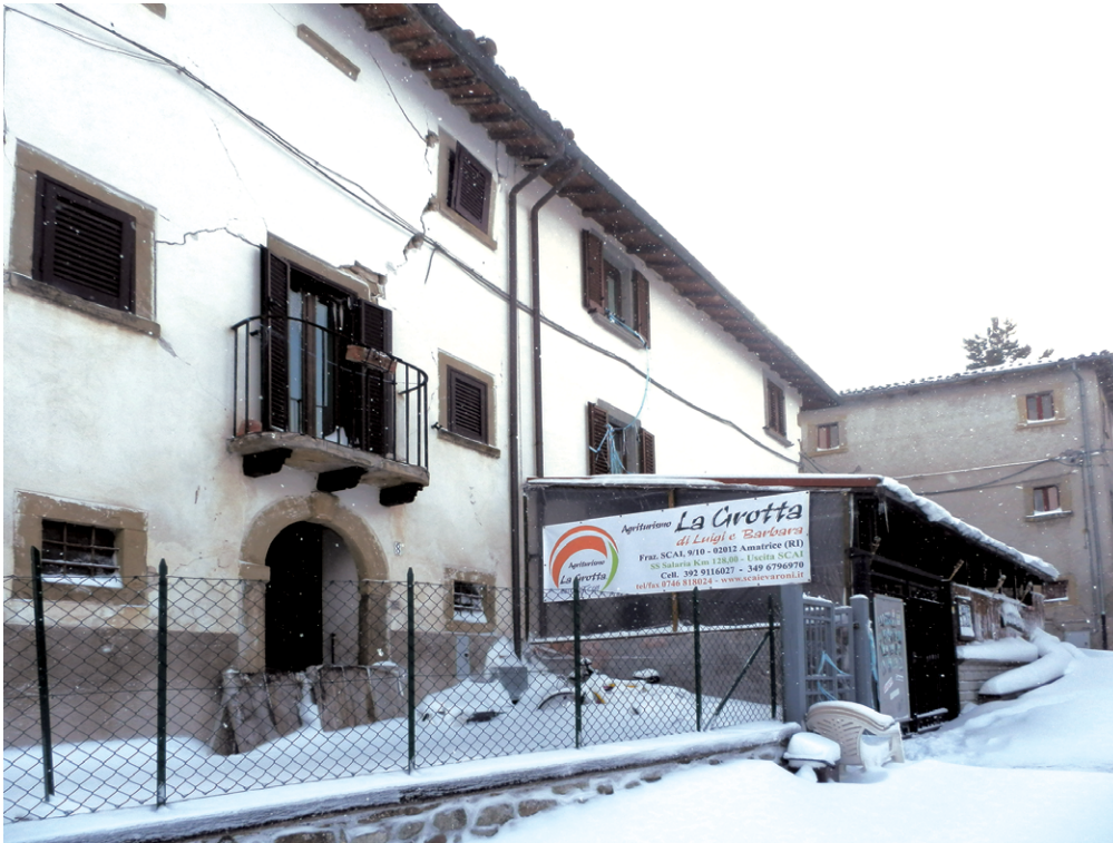
Figura 14 Edificio 18 pre sisma e post sisma in data 17/1/2017.
