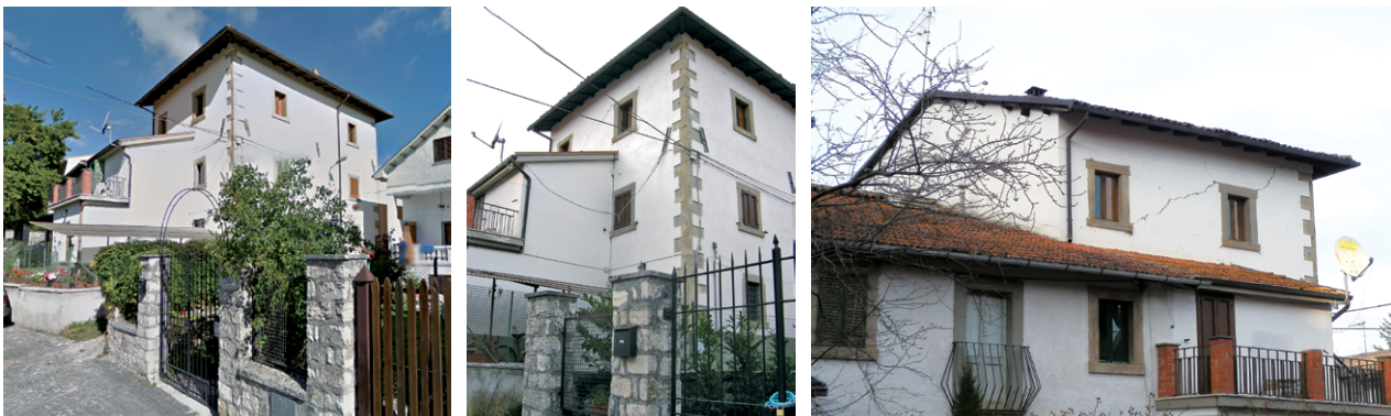
Figura 15 Edificio 9 pre sisma e post sisma in data 1/12/2016.
