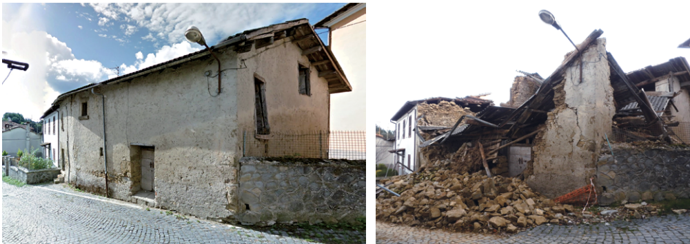
Figura 18 Edificio 15 pre sisma e post sisma in data 1/12/2016.
