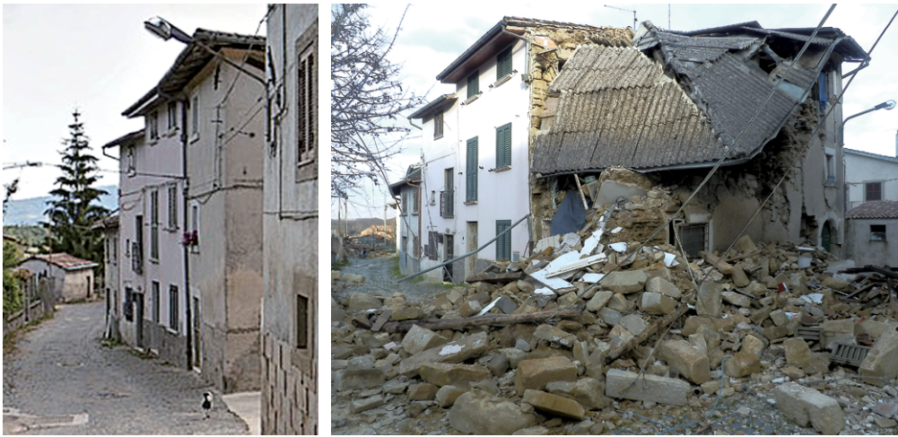
Figura 17 Edificio 7 pre sisma e post sisma in data 1/12/2016.
