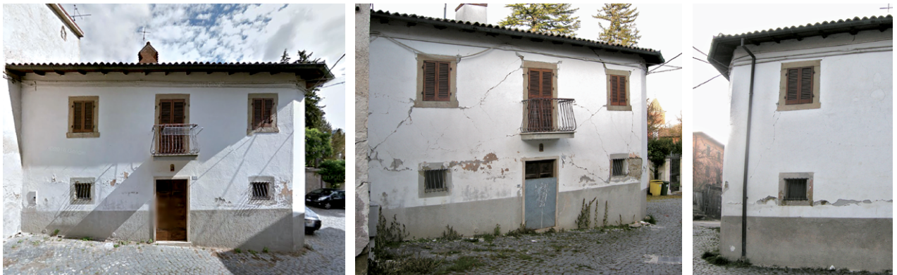
Figura 8 Edificio 11 pre sisma e post sisma in data 1/12/2016 (in basso).
