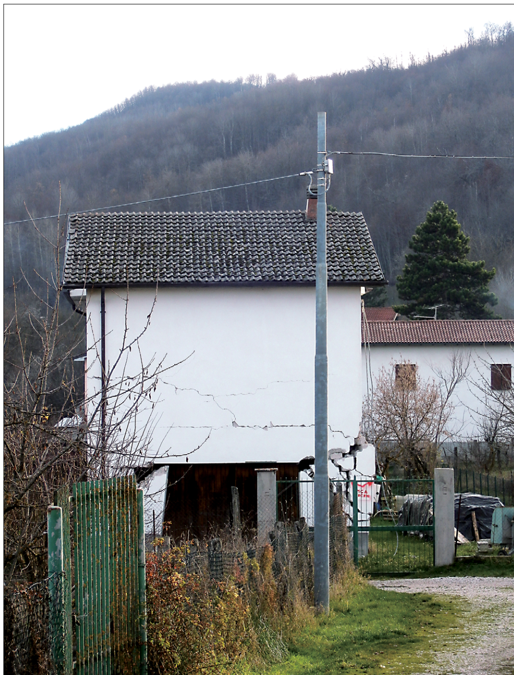
Figura 26 Edificio 20 in data 1/12/2016.
