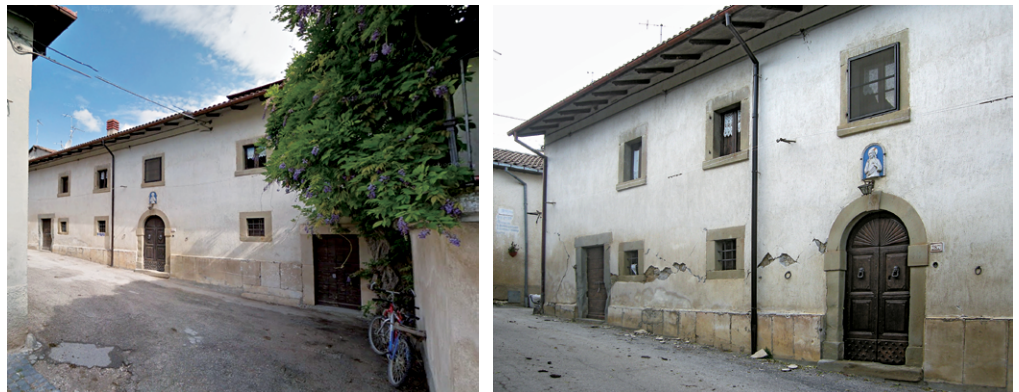
Figura 7 Edificio 10 pre sisma e post sisma in data 1/12/2016.
