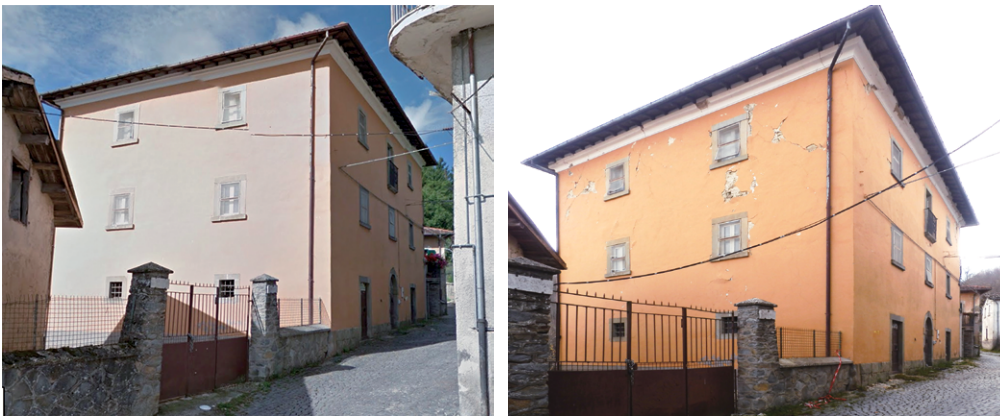
Figura 10 Edificio 14 pre sisma e post sisma in data 1/12/2016.
