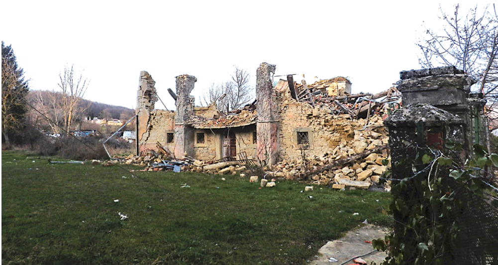
Figura 19 Edificio 21 in data 1/12/2016.
