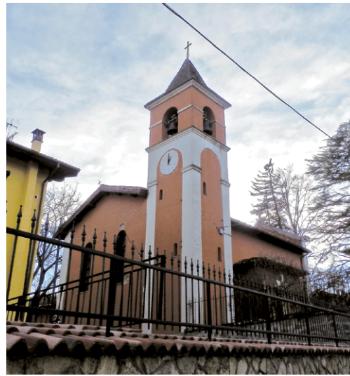
Figura 28 Chiesa di San Sebastiano pre-sisma e post sisma in data 1/12/2016.
