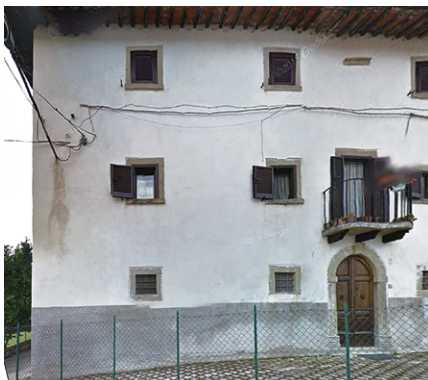
Figura 13 Edificio 18 pre sisma e post sisma in data 17/1/2017.
