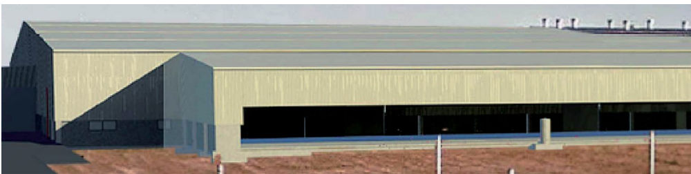
Figura 16 Struttura adibita a magazzino e centro di distribuzione in Nuova Zelanda.
