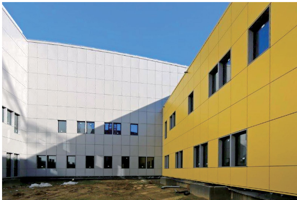
Figura 12 Pannelli di facciata cieca/ vetrata oggetto di verifica.
