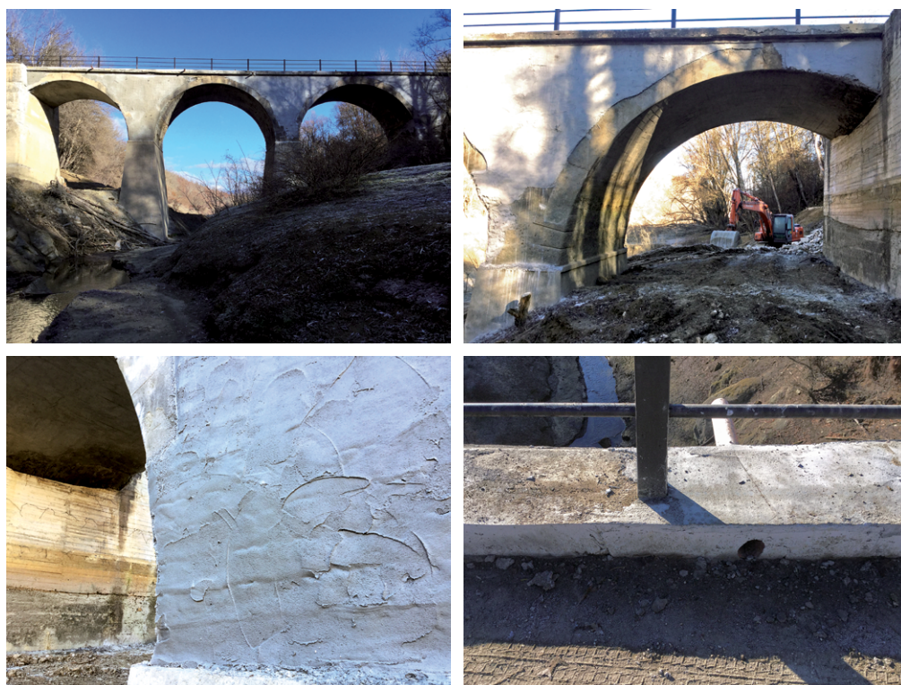
Figura 9 Ponte a Cinque Occhi dopo i lavori di consolidamento statico: superfici murarie riparate con cementi fibrorinforzati e sistemazione dei cordoli perimetrali della carreggiata e tubazioni di deflusso acque sede viaria.
