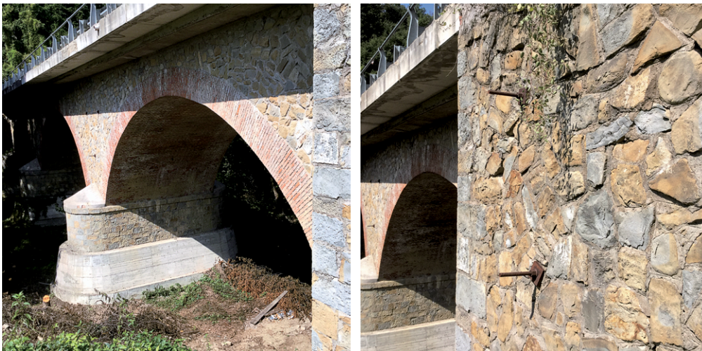
Figura 3 Vista laterale del Ponte a Tre Occhi (sinistra) e particolare interventi strutturali (destra).
