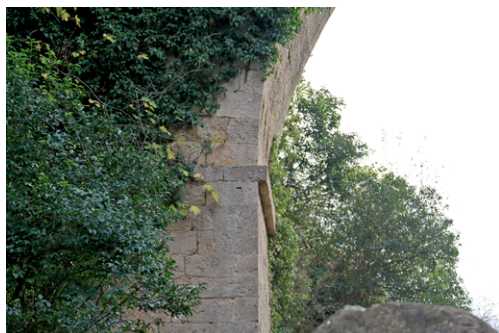
Figura 12 Imposta dell'arco e pila in muratura.
