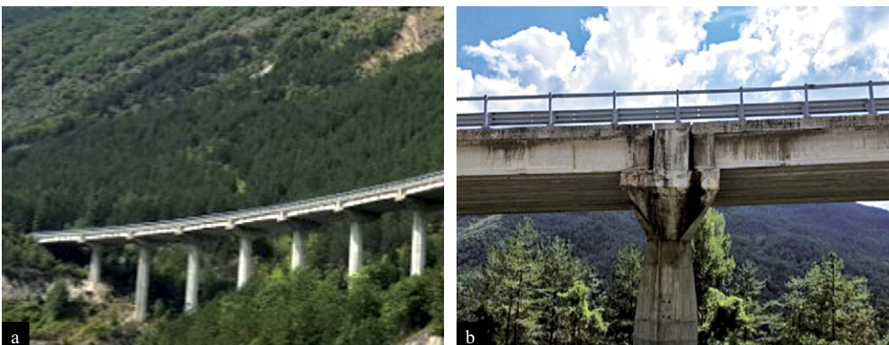
Figura 13 Configurazione tipica dei viadotti in c.a. ispezionati lungo la SS685 in prossimità di Pescara del Tronto (AP): (a) coordinate 42.752002 N, 13.267902 E; (b) coordinate 42.756556 N, 13.277111 E.
