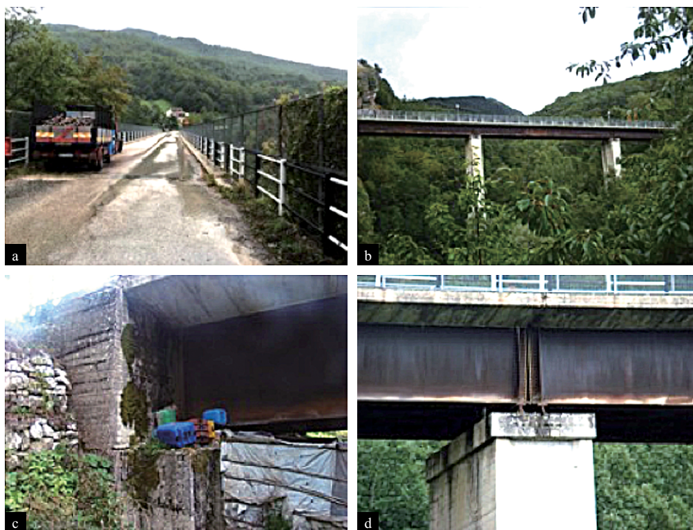
Figura 19 Ponte Ramazzotti - Struttura composta acciaio- calcestruzzo (42.7276 deg, 13.311 deg): vista generale del ponte (a, b), spalla (c) appoggi (d).
