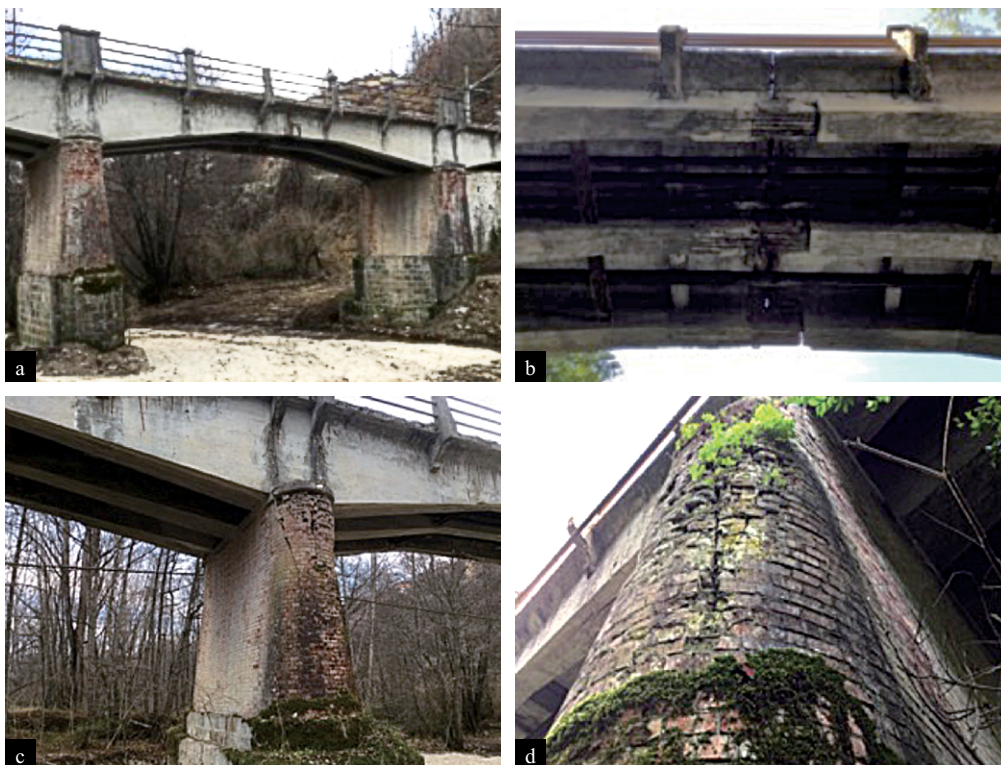
Figura 18 Ponte Rosa: (a) vista generale del ponte; (b) particolare sella Gerber; (c) appoggio delle travate in corrispondenza di una pila in muratura; (d) stato manutentivo delle pile in muratura.
