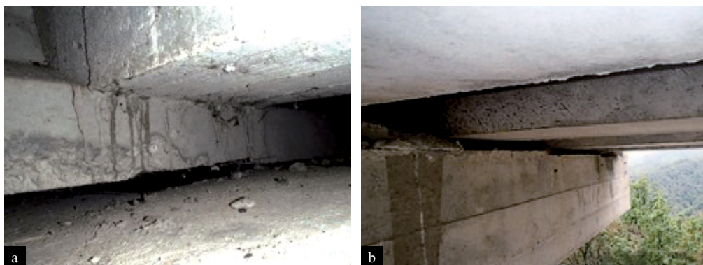
Figura 15 Appoggi elastomerici di uno dei viadotti in c.a. esaminati lungo la SS685; non si notano segni di eventuali scorrimenti relativi (per concessione di Totaro).
