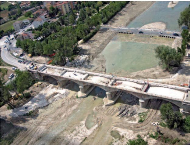
Fig. 25 - Foto aeree del ponte svotato. Si notano i pulvini già realizzati.
