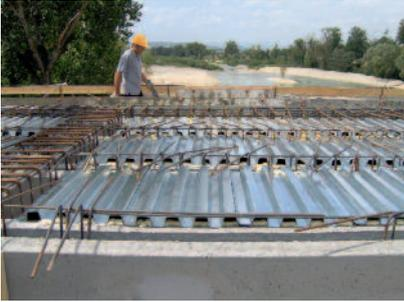
Fig. 34 - Lamiera grecata utilizzata come cassero e connettori a taglio tra le travi prefabbricate e la soletta superiore dell'impalcato.
