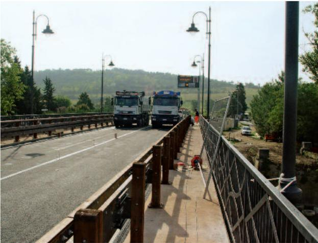
Fig. 37 - Collaudo strutturale dell'opera.
