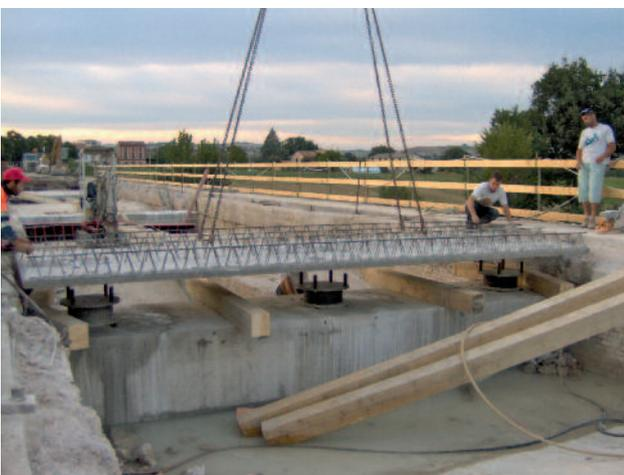
Fig. 27 - Posa del cassero a perdere prefabbricato delle travi diaframma.
