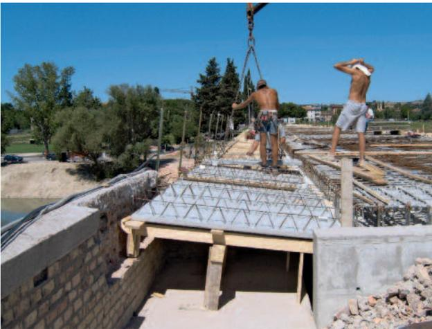
Fig. 30 - Posa degli sbalzi laterali. In primo piano il parapetto in muratura soprastante il muro d'ala sinistro della spalla e il retro del muro paraghiaia in cls realizzato per il sostegno della rampa di raccordo dovuta all'innalzamento del piano viario del ponte.
