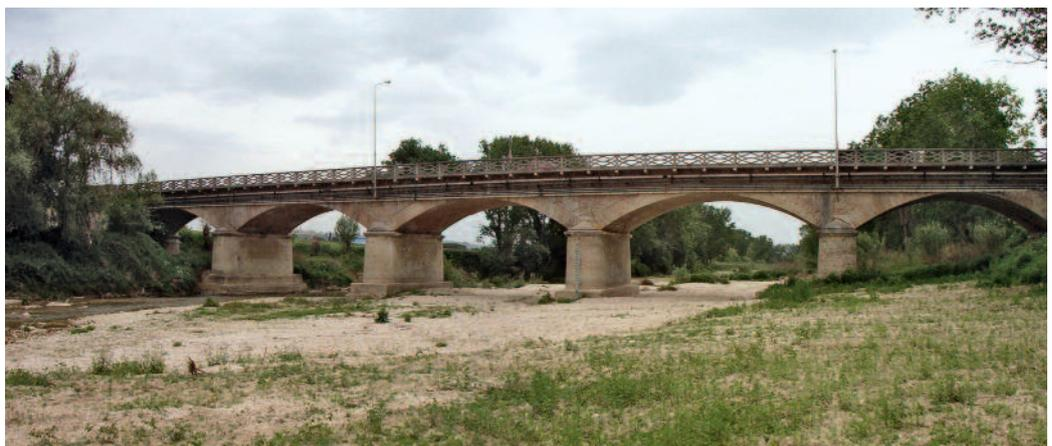
pata e larghezza costante di 7,60 m. Il piano viario correva a circa 10 m dal greto del fiume. Le quattro pile, costituite da un rivestimento esterno in muratura piena di spessore pari a 0,6 m e da un riempimento interno costituito da un calcestruzzo a basso contenuto cementizio, avevano sezione rettangolare con dimensioni in pianta di 2,6 m x 8,0 m ed erano protette dal flusso dell'acqua fluviale da rostri costruiti in pietra e muratura.
