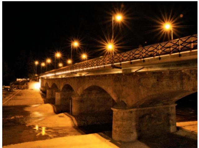
Fig. 18 - Viste laterali del ponte, si notano l'innalzamento del piano viario e il conseguente distacco tra il nuovo e il vecchio marciapiede evidenziato dal sistema di illuminazione interno in corrispondenza dei pulvini e delle travi diaframma.
