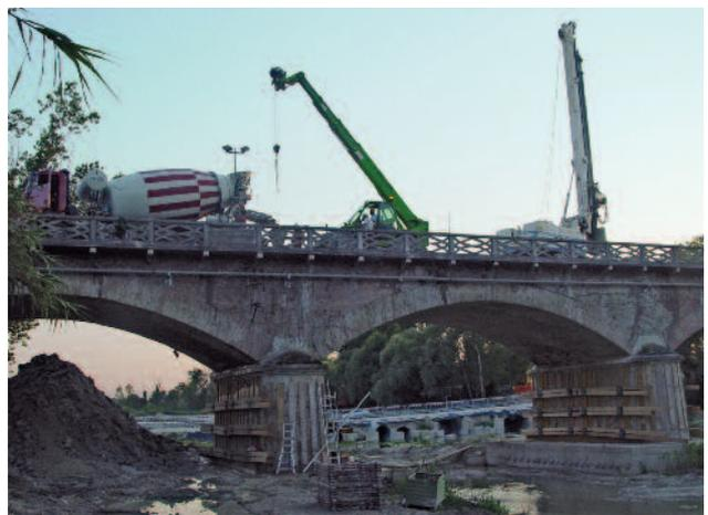
tasei ore superiore a 20 MPa (Fig. 21 e 22). L'esecuzione dei pali nelle spalle è stata complicata dall'intercettazione di una successione di strati a durezza variabile, con presenza di pietra e legno, probabilmente dovuti alla tecnica costruttiva adottata per realizzare le spalle, in corrispondenza dell'imposta della fondazione dei muri di ripa.
