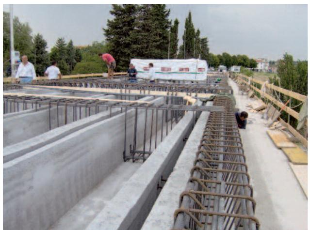
Fig. 33 - Armatura dei travi di irrigidimento trasversali dell'impalcato e trave trapezoidale di bordo.
