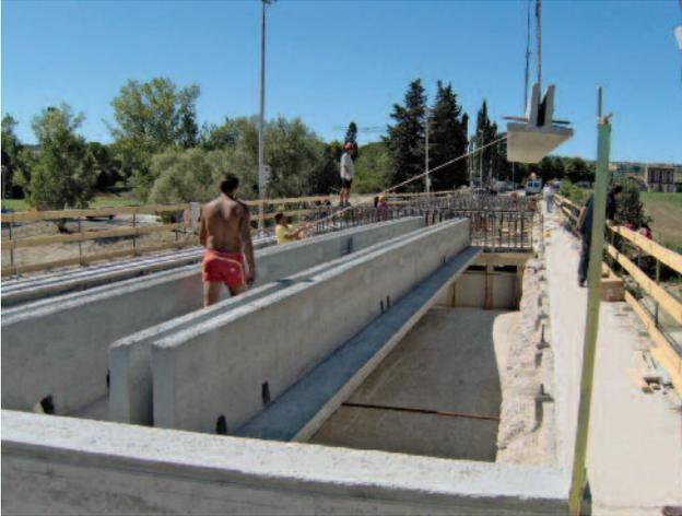
Fig. 29 - Posa delle travi prefabbricate.
