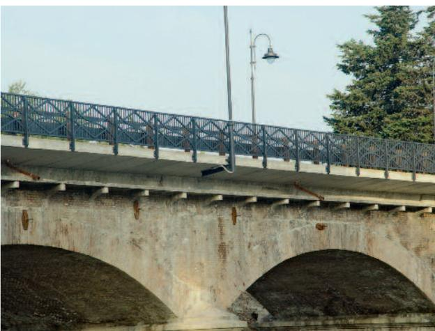
Fig. 32 - Sbalzi laterali ultimati si notano l'aggancio del sistema d'illuminazione e il sistema di smaltimento delle acque meteoriche in rame.
