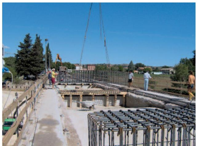
Fig. 28 - Posa delle gabbie d'armatura delle travi diaframma precedentemente montate a piè d'opera.
