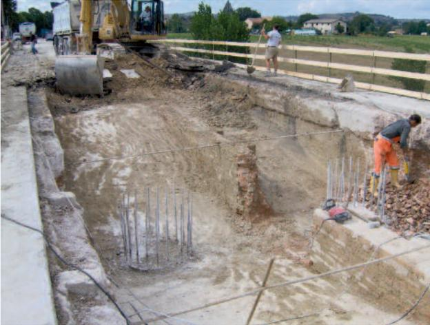
Fig. 23 - Svotamento del ponte, si notano le teste dei pali già eseguiti con attraversamento a vuoto nei primi due metri circa. Sulla destra si nota l'operaio intento nel realizzare la buca d'accesso per l'ispezionabilità degli isolatori.
