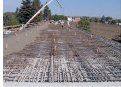
Fig. 36 - Fasi di getto della seconda metà della soletta superiore.
