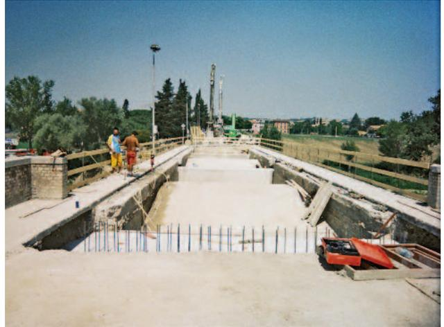
Fig. 24 - Prima metà del ponte svotata con i pulvini già realizzati.
