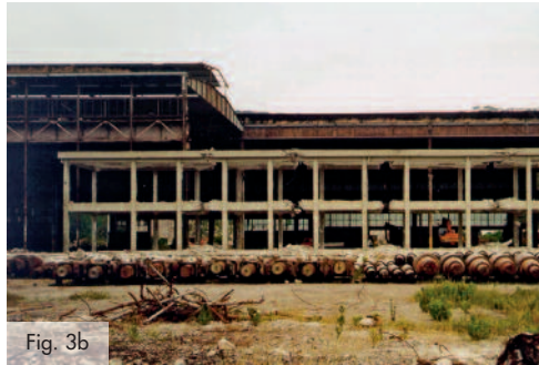
Fig. 3. L'edificio in cemento armato oggetto di sperimentazione nel progetto ILVA-IDEM: (a) la costruzione originaria; (b) la suddivisione in sei sotto-strutture a cui sono state applicate differenti tecniche di consolidamento.
