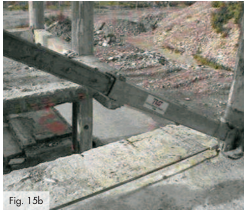
Fig. 15 Struttura consolidata mediante controventi con leghe a memoria di forma: (a) posizione dei controventi; (b) dettaglio dell'attacco di un controvento alla struttura in c.a. esistente.
