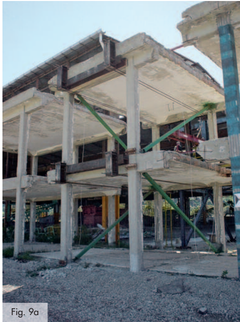
Fig. 9 Consolidamento con BRB (ILVA-IDEM): (a) disposizione dei controventi; (b) struttura di contrasto.
