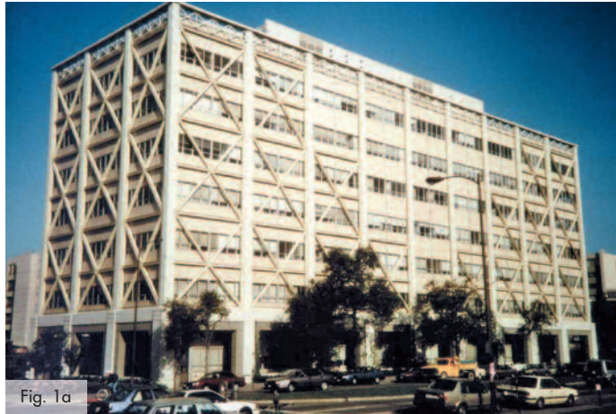
Fig. 1 Esempi di consolidamento di edifici in c.a. esistenti mediante controventi in facciata (Berkeley, Stati Uniti): (a) University Hall; (b) garage multi-piano.
