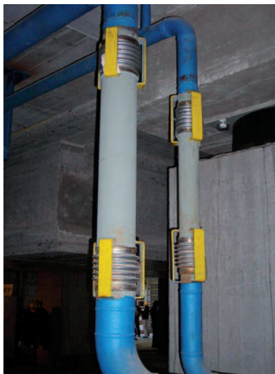
Fig. 26 Giunti flessibili utilizzati per gli impianti: vista di insieme (sopra) e particolare di attacco (sotto).
