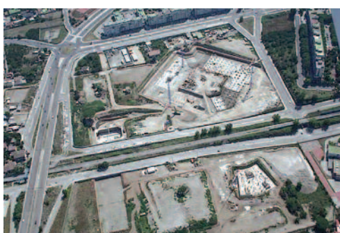
Fig. 4 Vista aerea del sito di realizzazione del nuovo complesso ospedaliero nella fase iniziale di realizzazione (sopra) e particolare dell'edificio ospedaliero in fase di completamento (sotto).
