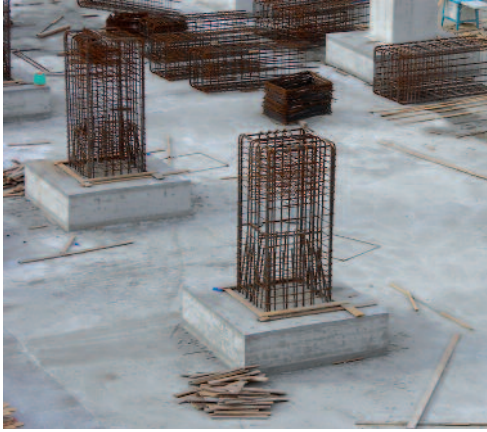
Fig. 22 Particolare delle pile e del pulvino.
