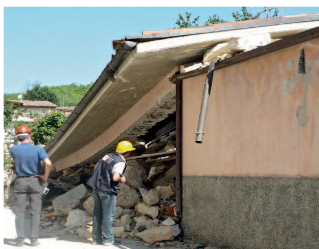
Fig. 25 Villa Sant'Angelo: crollo diffuso della cimasa muraria senza coinvolgimento delle aperture.
