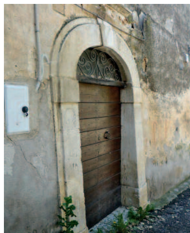
Fig. 6 Sant'Eusanio Forconese: parete a scarpa costruita contestualmente all'edificio.
