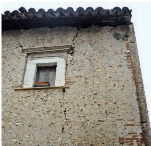
Fig. 37 Castelnuovo: distacco della parete di facciata per difetto di ammassatura con la parete laterale.
