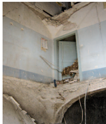
Fig. 31 Poggio Picense: evidente deformazione della parete muraria di facciata con massimo in corrispondenza della quota dell'orizzontamento di interpiano.
