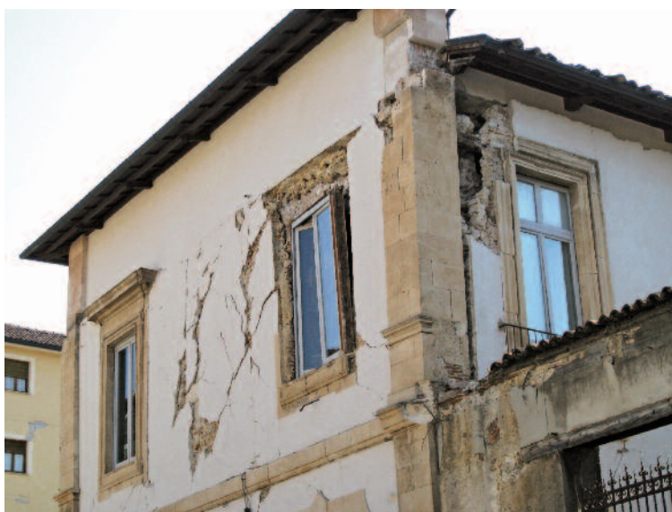
Fig. 42 Villa Sant'Angelo: lesioni di taglio che attraversano tutta la parete di facciata.
