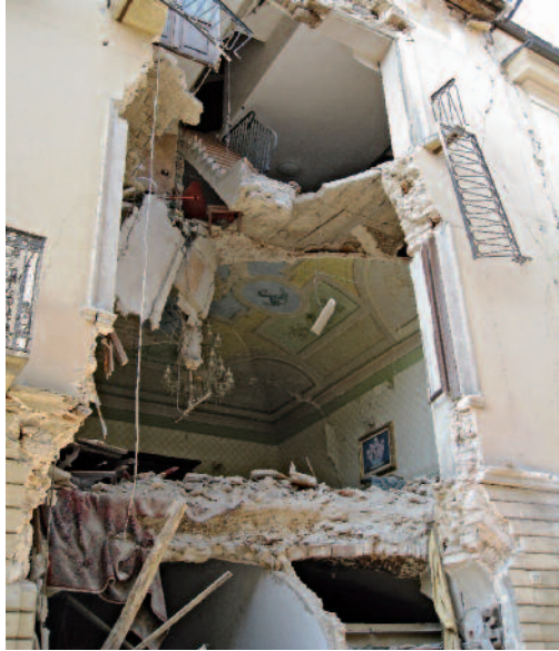
Fig. 29 L'Aquila: al solaio del secondo interpiano erano state sovrapposte una soletta e una scala in c.a.
