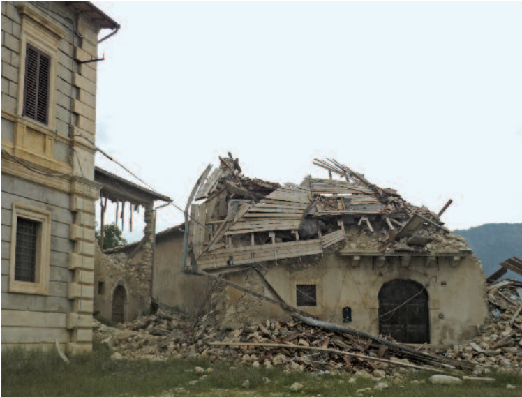
Fig. 46 Castelnuovo: crollo totale del piano sommitale per difetto della qualità muraria.
