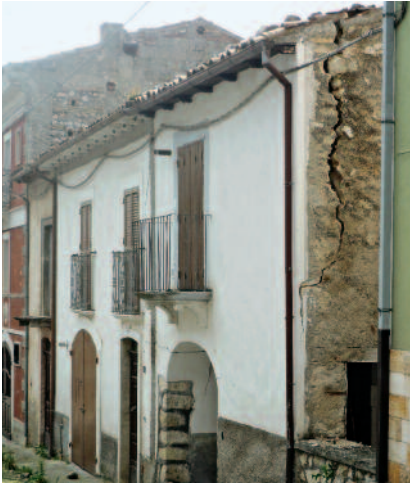
Fig. 37 Castelnuovo: distacco della parete di facciata per difetto di ammassatura con la parete laterale.
