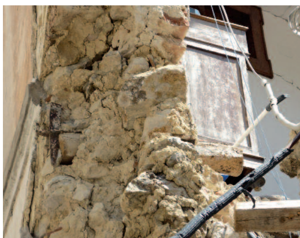
Fig. 17 Tempera: crollo di edifici posti a testata di aggregati lineari.
