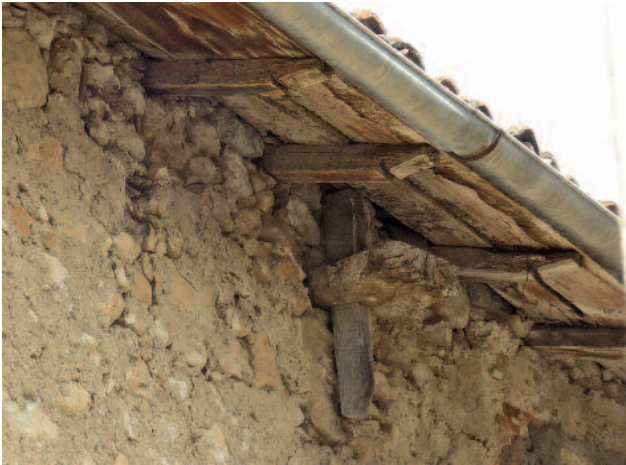
Fig. 21 Villa Sant'angelo: capochiave ligneo di riscontro alla catena della capriata lignea.
