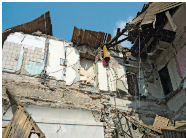
Fig. 17 Tempera: crollo di edifici posti a testata di aggregati lineari.
