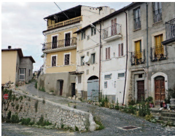
Fig. 1 Castelnuovo: prospetto a valle di edifici a fronte monocellulare su pendio.
