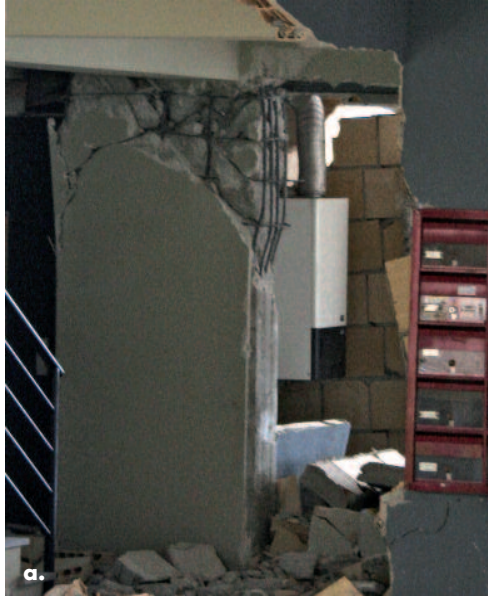
Fig. 6 Crisi a taglio di pilastri.
