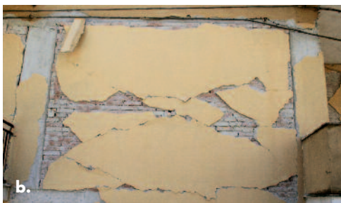
Fig. 12 Crisi di pannelli di tamponatura per fessurazione diagonale (a), (b) o per schiacciamento degli spigoli (c).
