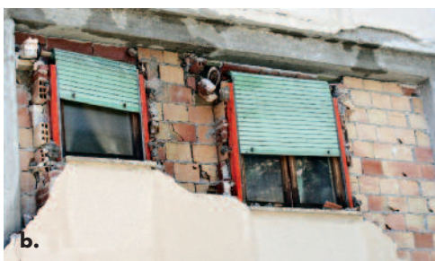
Fig. 15 Crisi di tamponature con differenti tipologie di aperture.
