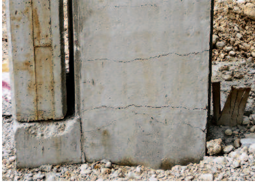
Fig. 5 Danni locali alla base di un pilastro e di un pannello di tamponatura.
