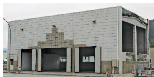
Fig. 4 Edificio con pannelli orizzontali caduti lungo una facciata.
