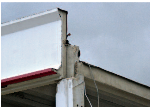
Fig. 13 Ribaltamento di travipannello di facciata.
