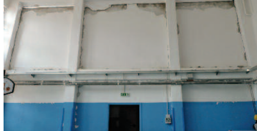
Fig. 5 Lesioni e distacchi di intonaco sui tramezzi della scuola elementare di Paganica.
