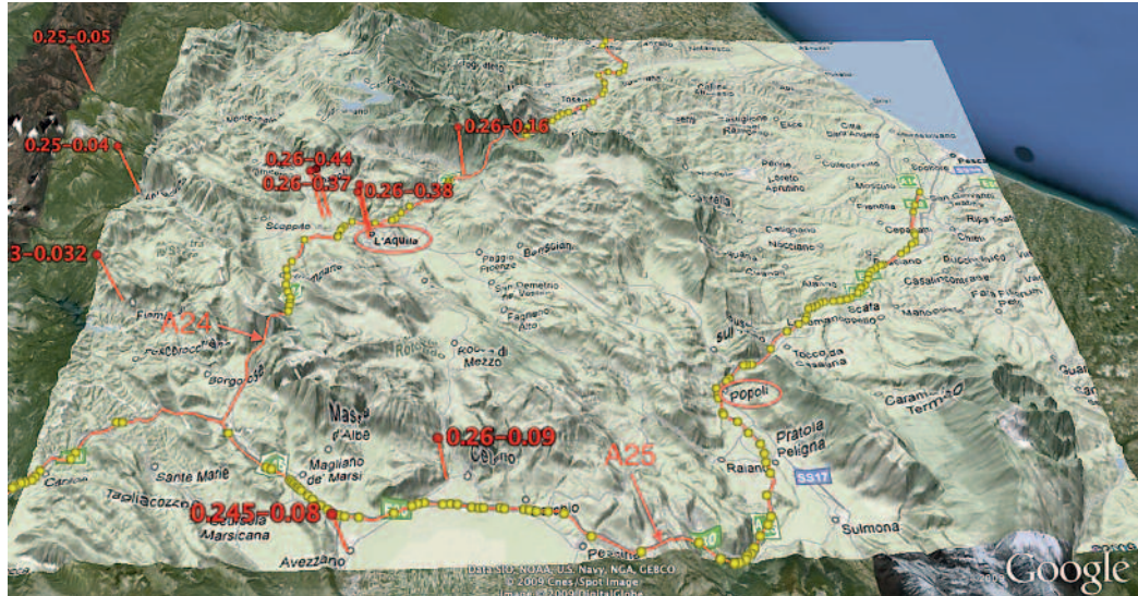
Fig. 2 Area interessata dal sisma del 6 aprile 2009. Sono evidenziati il tracciato della A24 e della A25 a partire da Torano (in arancione), la posizione di ponti e viadotti (in giallo), la posizione delle stazioni accelerometriche nell'area (in rosso). In corrispondenza delle stazioni sono riportati due valori di accelerazione di picco al suolo (in g), il primo è quello dalla mappa di pericolosità per T_R = 475 anni, e il secondo è quello registrato.
