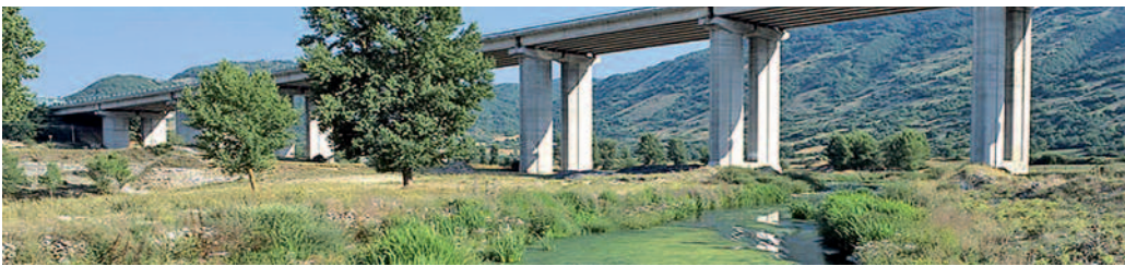
Fig. 1 Tipico viadotto dell'autostrada dei Parchi.
