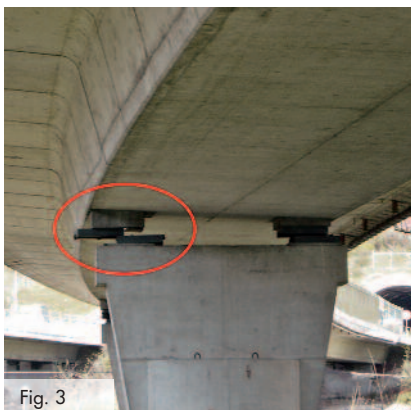
Fig. 5 Viadotto Popoli, danni alle spalle: espulsione dei rulli dagli appoggi mobili e danneggiamento del controbaggiolo.
