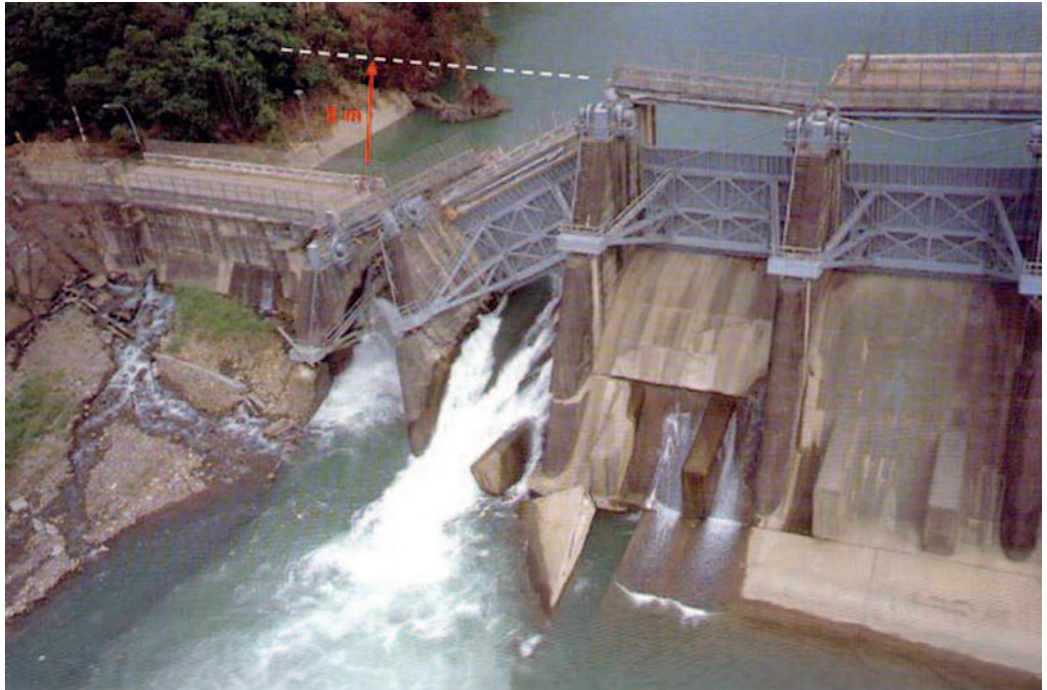
Fig. 6 Diga Shih-Kang attraversata dalla faglia Chelungpu durante il terremoto di Chi- Chi (Taiwan) del 1999 (immagine adattata da Faccioli e al. (2008) da Hwang, 2000).
