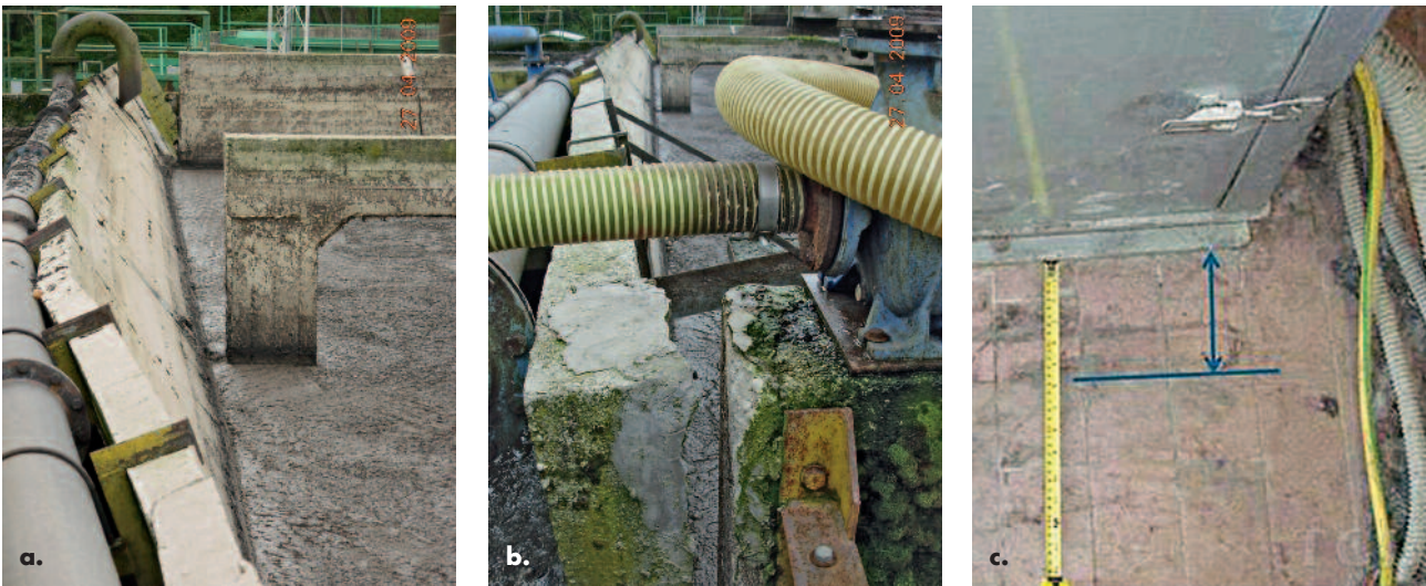
Fig. 3 (a) Impianto Ponte Rosarolo. Vasca di digestione: crollo parziale di una parete longitudinale e della tubazione collegata. Foto 3 - Impianto Ponte Rosarolo. (b) Vasca di digestione: dettaglio del distacco delle pareti ortogonali in corrispondenza degli spigoli. (c) Spostamento della pompa nella sala di controllo.
