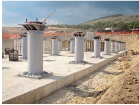
Fig. 20 Armatura di una piastra di fondazione con chiamate per pilastri in calcestruzzo e piastra con colonne in acciaio ed isolatori già posati.
