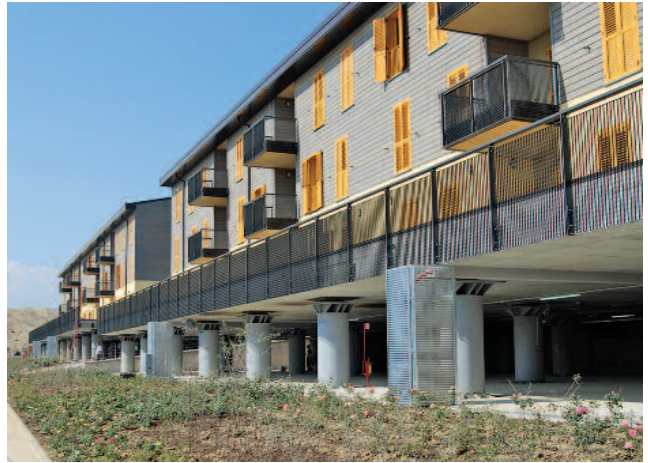
Fig. 22 Esempi di edifici completati.
