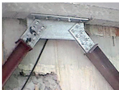
Fig. 22 Esempi attacchi dei controventi alla struttura esistente.
