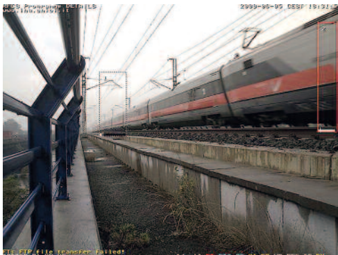
Fig. 38 Viadotto Sesia: esempio di registrazione video al passaggio del convoglio ferroviario.
