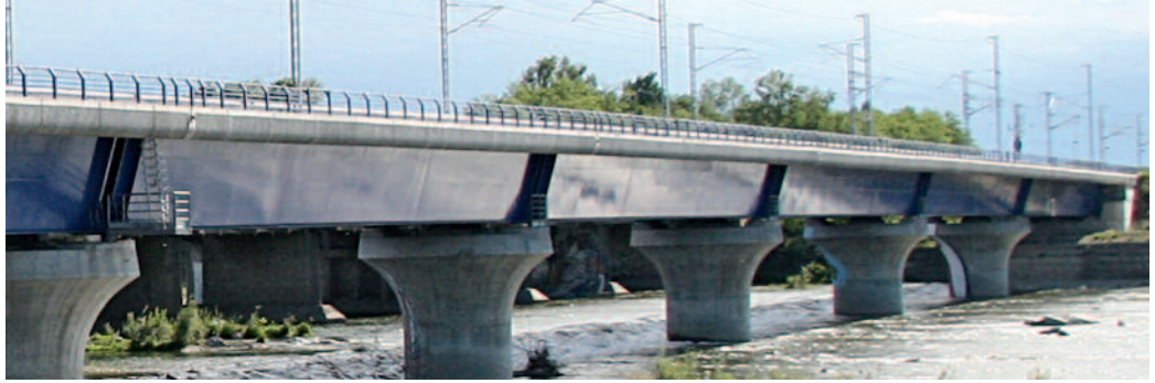
Fig. 30 Vista generale del viadotto Sesia.
