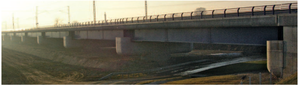
Fig. 25 Viadotto Elvo: vista generale dell'intero viadotto.
