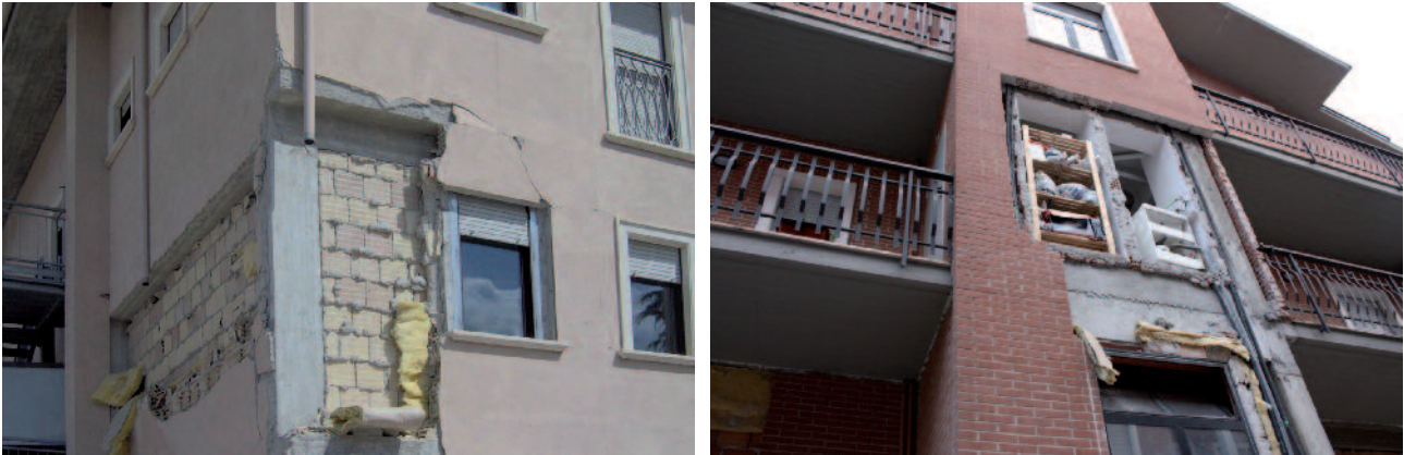
Fig. 2a Paramento esterno della tamponatura collocate su solette esterne al reticolo strutturale.
