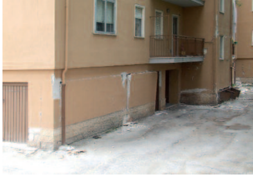
Fig. 4a Danneggiamento per azioni fuori dal piano: collasso incipiente per ribaltamento del pannello di tamponatura.
