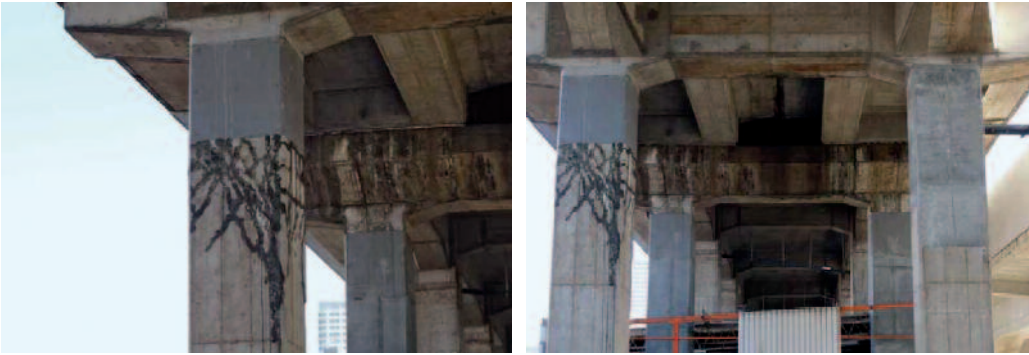
Figura 15 Zona di Asuto Nagamachi 2- chôme: lavori di riparazione ultimati mediante iniezione di resina plastica al di sotto del pre-esistente intervento di fibrorinforzo.
