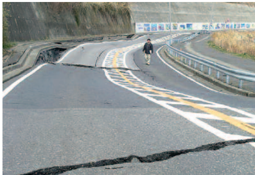
Figura 30 Distorsione differenziale della pavimentazione stradale in una zona residenziale di Mihama di Chiba.
