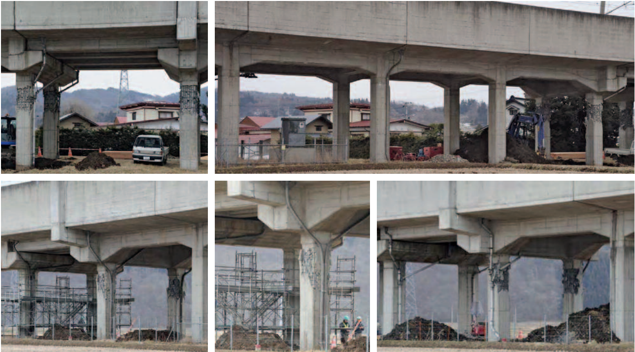
Figura 19 Espulsione del copriferro notata sulla pila R1-5 (a sinistra) e su quelle della parte R2 (a destra).
