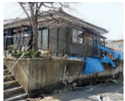
Figura 10 Oritate 5-chôme - Danneggiamento di un edificio (a sinistra) e danneggiamento dei muri di contenimento (al centro e a destra) causati dallo scorrimento del terreno.
