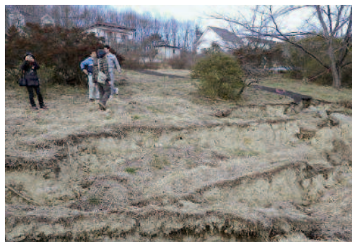
Figura 34 Distorsione di un terrapieno ferroviario (Joban Line della Japanese Railway East, vicino a Mito, Ibaraki).
