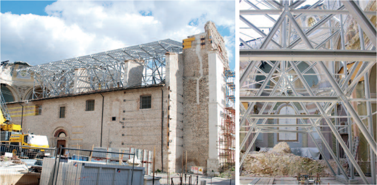
Figura 1 Vista della Chiesa di S.M. Paganica e della struttura spaziale di copertura in PFRP.
