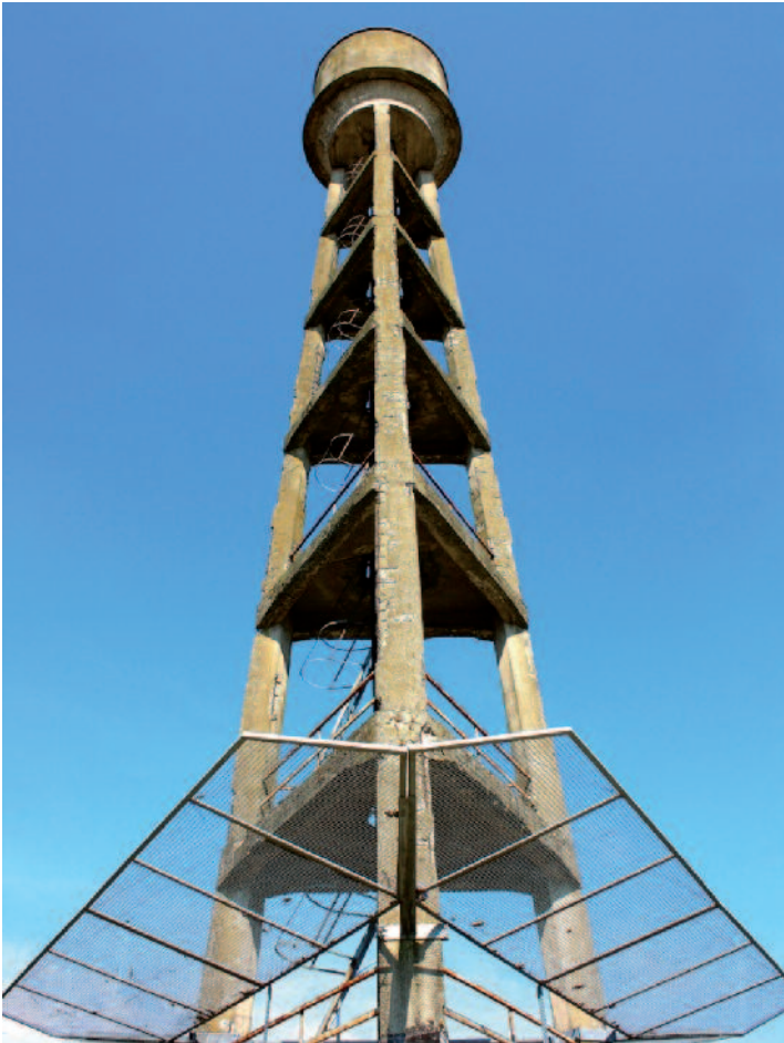
Figura 1 Serbatoio sopraelevato da 30 m 3 , San Cipriano Po (Pavia).
