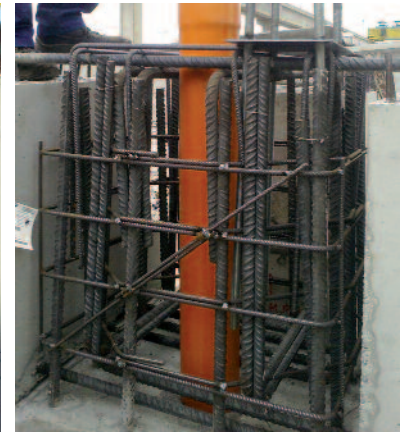
Figura 40 Disegno esecutivo nodo incastro centrale: la continuità avviene solo tra pilastro e travi rettangolari.
