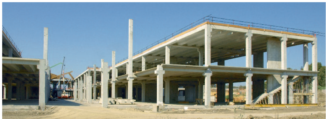
Figura 3 Lotto 2B in fase di costruzione.
