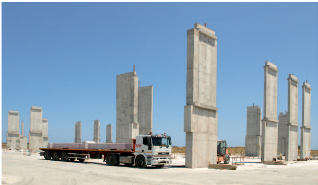
Figura 15 Setti nei Lotti 1A-1B in fase di costruzione.
