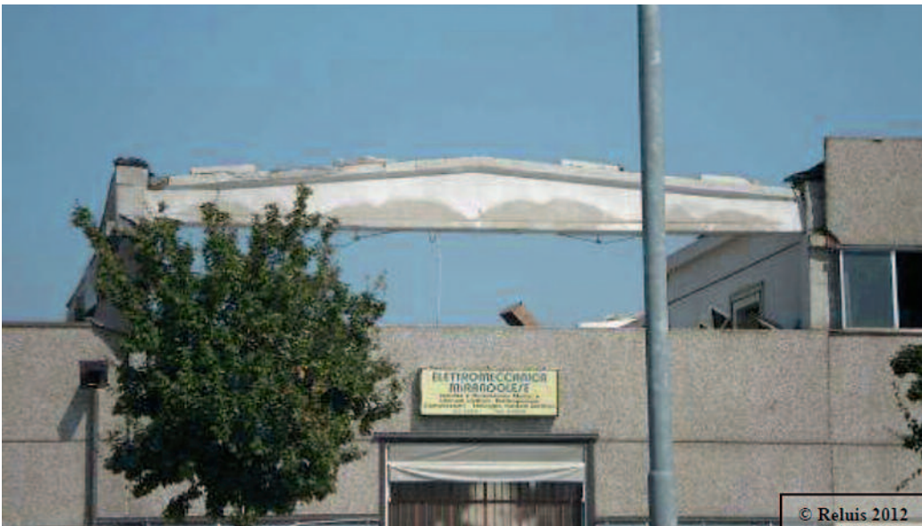
Figura 4 Collasso della copertura in tegoli prefabbricati e dei pannelli di tamponatura orizzontali.
