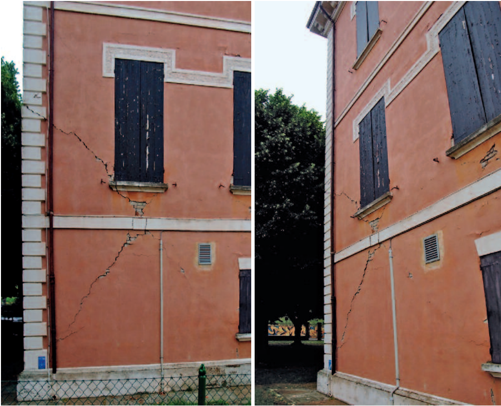
Figura 2 Scuola Gozzi - Camposanto - Esito E - Muratura.
