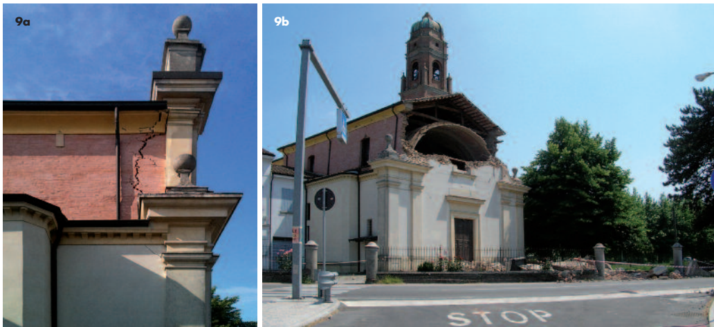
Figura 9 Rilevio danni strutture in muratura: 9a e 9b, Chiesa di San Giacomo Roncole dopo la prima e dopo la seconda scossa; 9c corpo antico dell'Ospedale di Finale Emilia; 9d struttura storica a Crevalcore.
