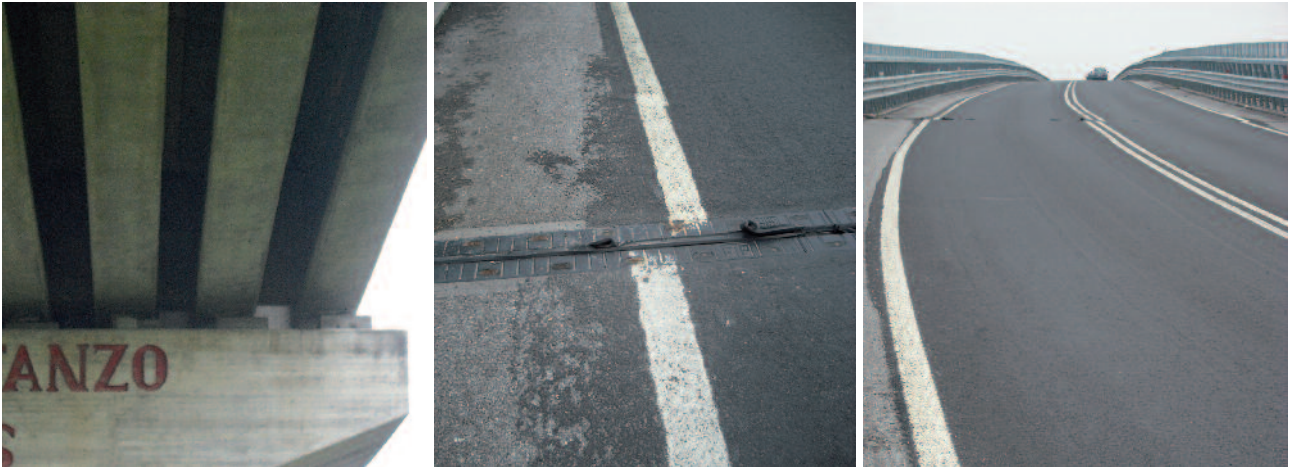
Figura 12 Rilievo danni sulle strutture da ponte – Finale Emilia.
