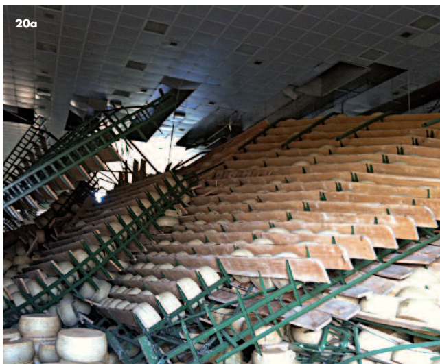
Figura 20 (a) Crollo di un magazzino di stagionatura di formaggi nel mantovano, (b) crollo del magazzino automatico contenente pallet di ceramica a S. Agostino.
