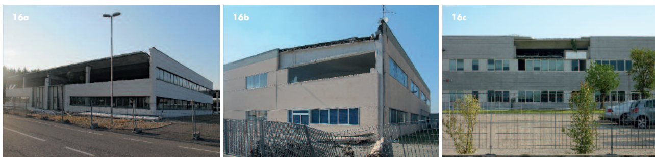
Figura 16 Caduta di pannelli di tamponamento prefabbricati disposti in orizzontale.
