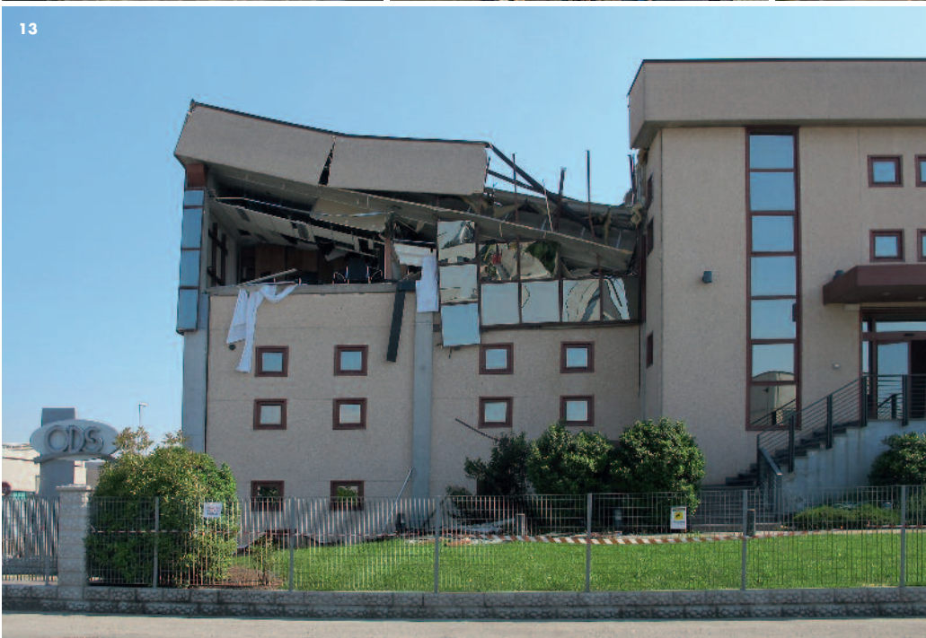
Figura 12 Crolli di elementi prefabbricati di copertura localizzati sovente in corrispondenza di irregolarità in pianta dei fabbricati.
