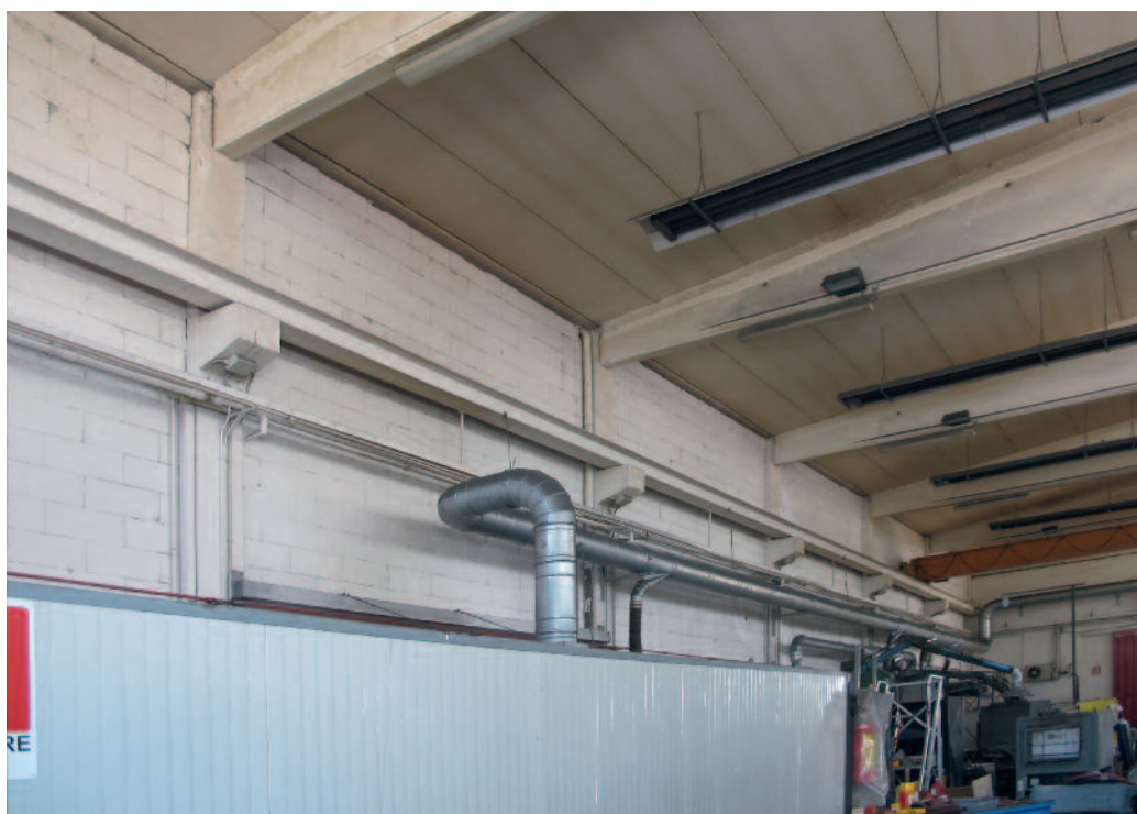
Figura 1 Mirandola - Edificio prefabbricato con trave a doppia pendenza e tamponamenti in muratura in luce trave-pilastri (prima della scossa del 29 Maggio).
