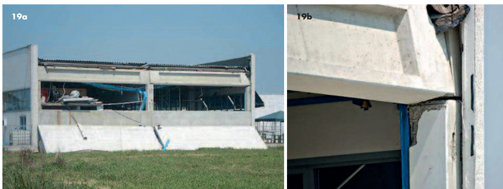
Figura 19 (a) Caduta dei pannelli di tamponamento e (b) dettaglio della rotazione laterale delle travi che sorreggono la copertura. Nella seconda immagine, in basso, si nota anche l'inefficienza dei sistemi di connessione (profili canale) dei pannelli ai pilastri.
