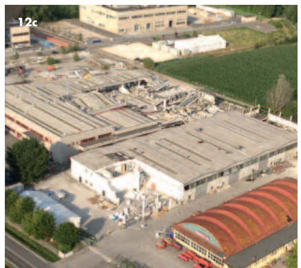
Figura 12 Crolli di elementi prefabbricati di copertura localizzati sovente in corrispondenza di irregolarità in pianta dei fabbricati.
