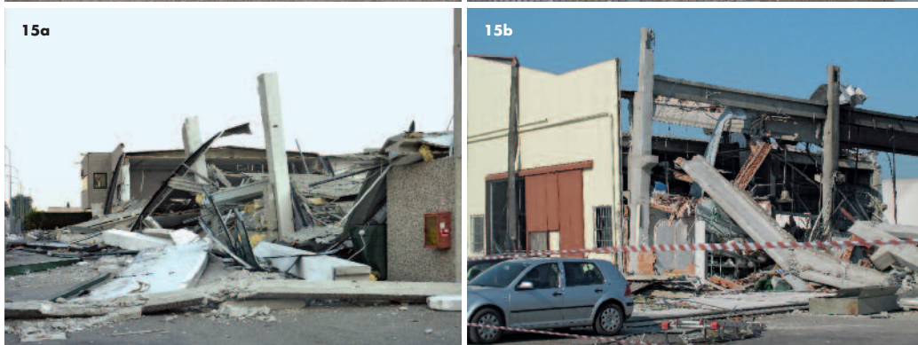
Figura 15 S. Agostino e Mirandola - Crolli completi di edifici industriali, con evidenti rotazioni alla base dei pilastri.
