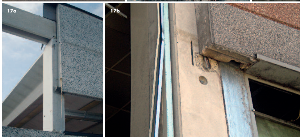
Figura 16 Caduta di pannelli di tamponamento prefabbricati disposti in orizzontale.
