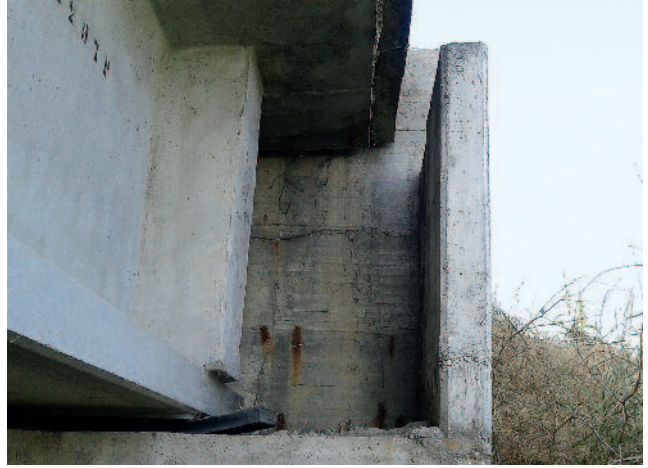
Figure 6 Ponte a San Felice sul Panaro. Particolare dello spostamento dell'impalcato che si è fermato a contatto con il muro paraghiaia a sinistra (giunto n°18, 27 cm).
