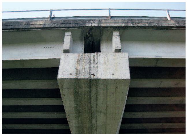
Figure 8 Ponte a San Felice sul Panaro. Vista sulle pile a setto (sinistra) e particolare dello spostamento longitudinale dell'impalcato sulle pile.
