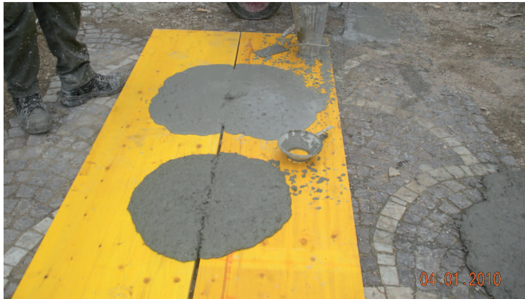
Figura 37 Verifica dello "Slump Flow"
