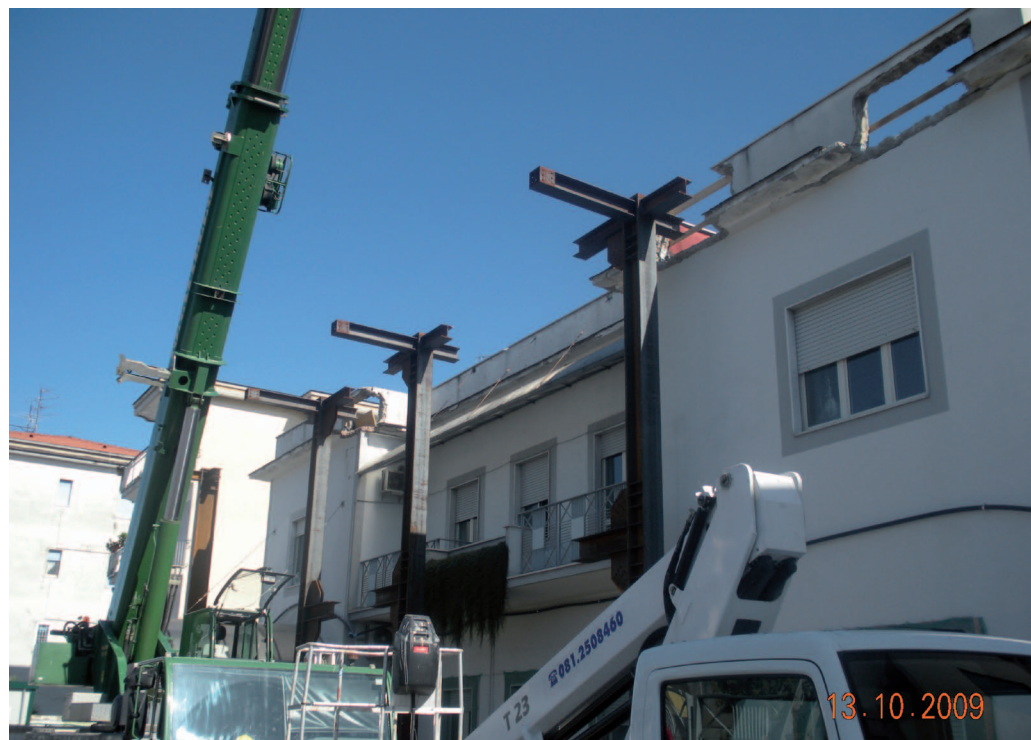
Figura 33 Posa delle colonne di facciata
