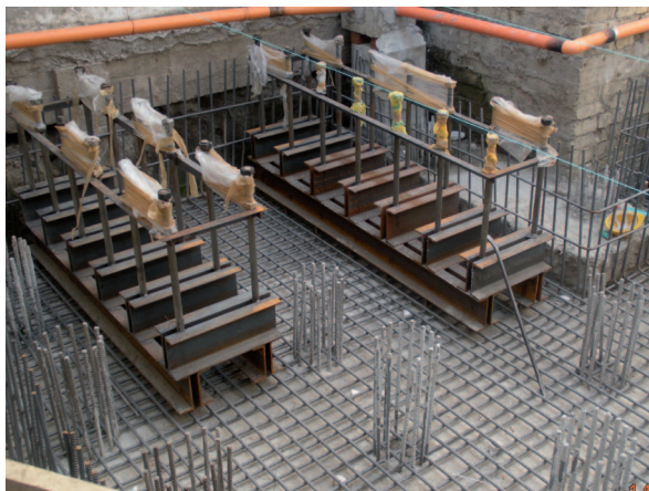
Figura 31 Dettagli della posa dei tirafondi
