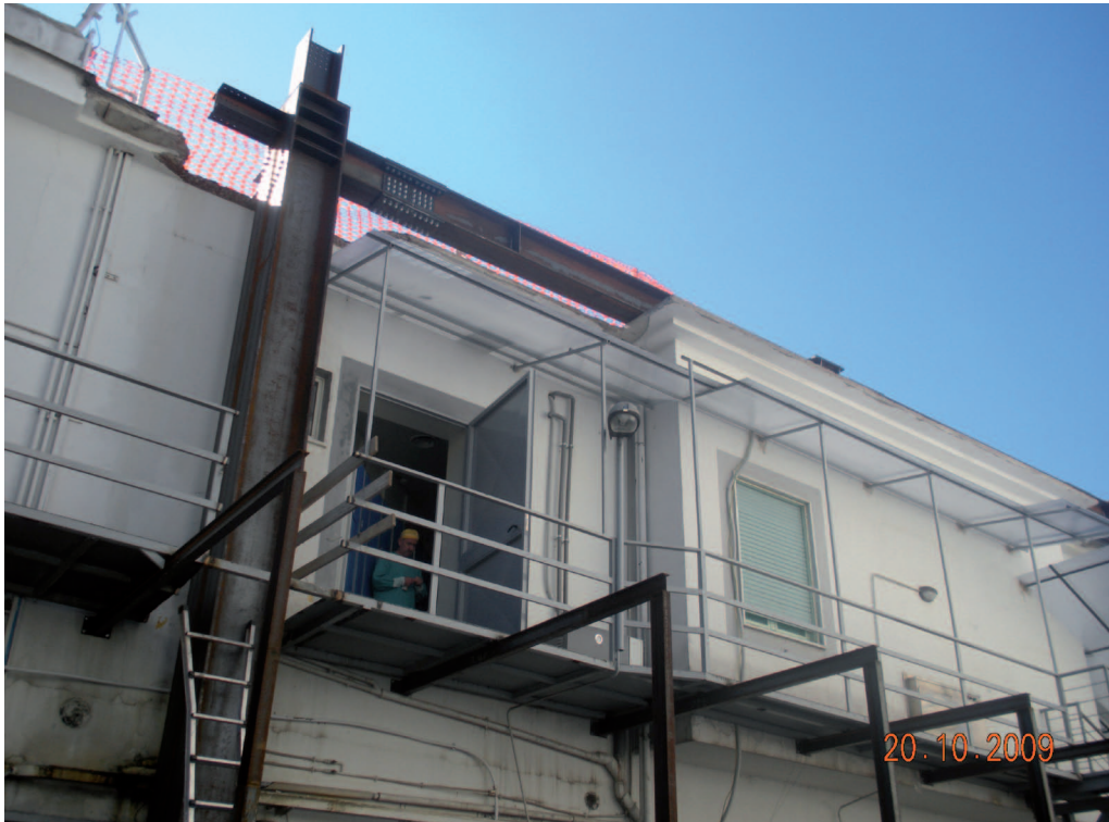
Figura 34 Posa travi e complesso operatorio ancora in funzione
