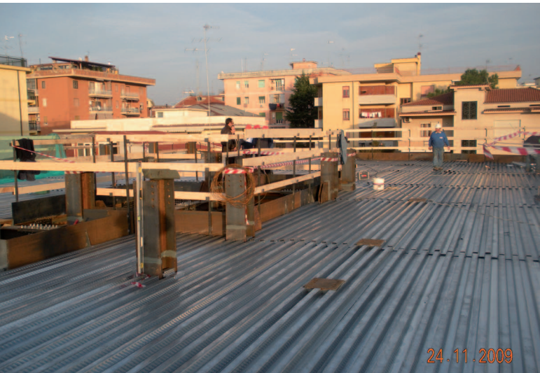
Figura 16 Posa lamiera grecata (2° impalcato)
