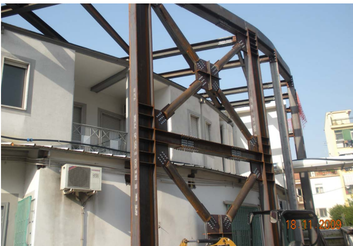
Figura 22 Ulteriori dettagli dei collegamenti fra gli elementi della struttura e vista della trave a sbalzo (a destra)
