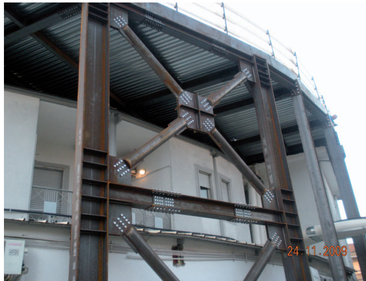
Figura 6 Particolare dei controventi concentrici del nucleo scala
