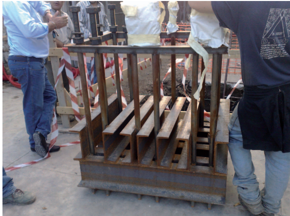
Figura 30 Dettaglio dei tirafondi
