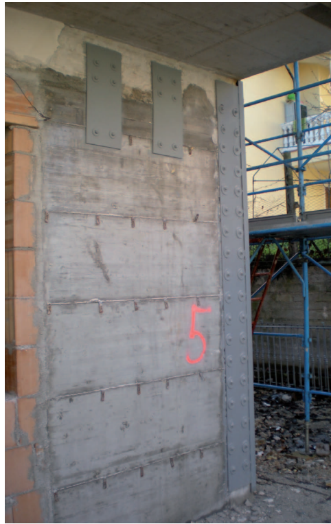
Figura 9 Rinforzo delle travi di fondazione. Dettaglio dei fori per il tassellamento dell'armatura di collegamento (in alto a sinistra), dettagli delle gabbie di armatura prima del getto (in alto a destra, al centro ed in basso).
