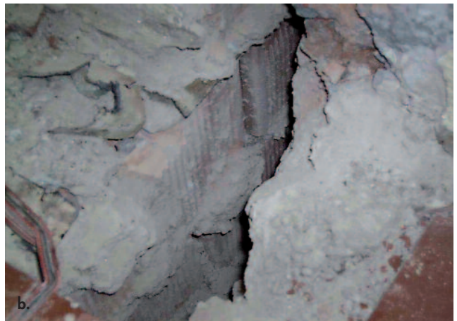
Figura 5 (a) Saggio su parete esterna e (b) saggio sul giunto presente tra i blocchi 4 e 5.
