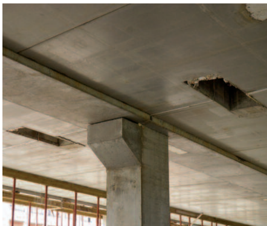
Figura 15 Alloggiamento shock transmitters.
