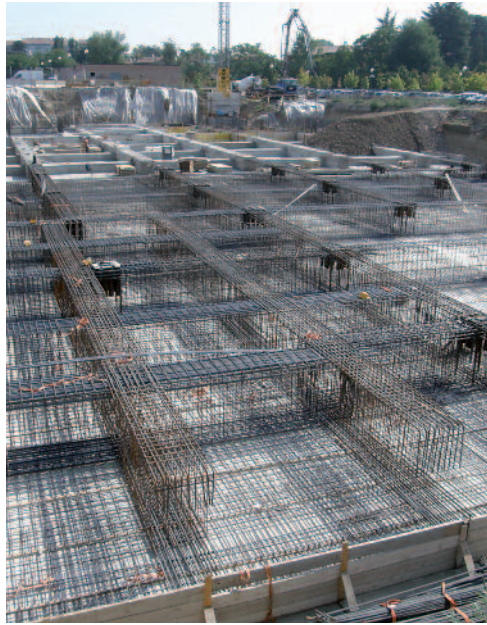
Figura 9 Realizzazione delle gabbie di fondazione.
