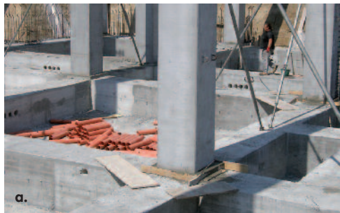
Figura 11 a) Inghisaggio dei pilastri; b) dettaglio dei collegamenti con le travi; c) dettaglio dei tirafondi in fondazione e posizionamento pilastro.
