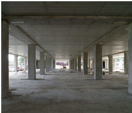
Figura 14 Solaio gettato.
