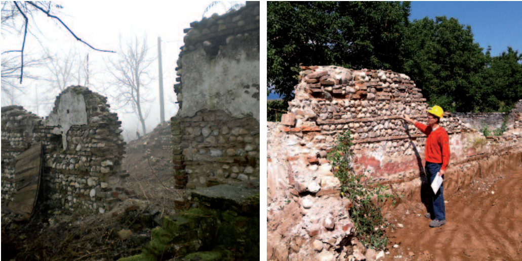
Figura 4 Muratura esistente in sasso da inserire nella nuova matrice strutturale.
