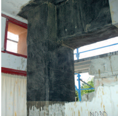
Fig. 1 Intervento di rafforzamento locale di nodi in c.a.
