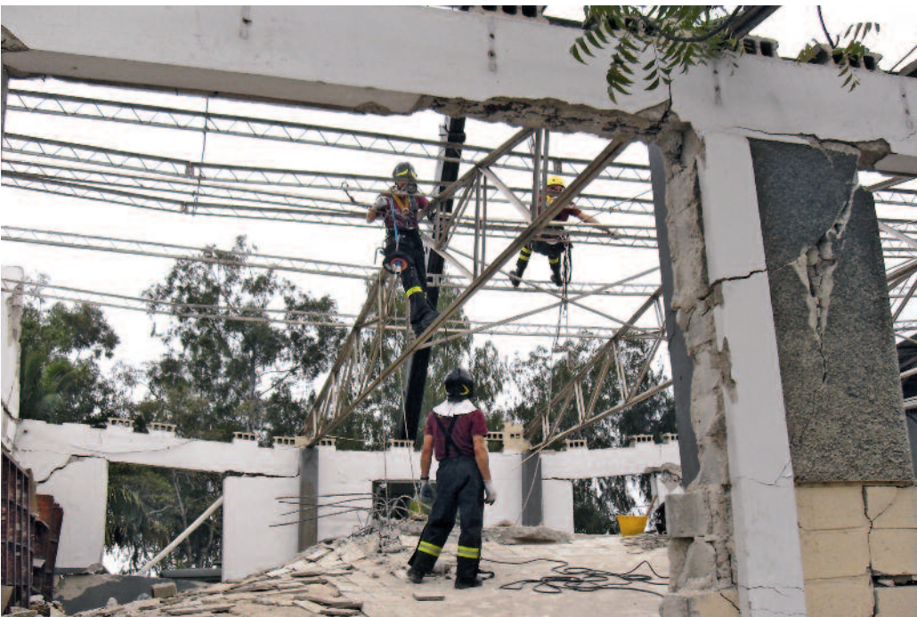
Fig. 4 Haiti; Immagine di un intervento di messa in sicurezza condotto dai V.F.
