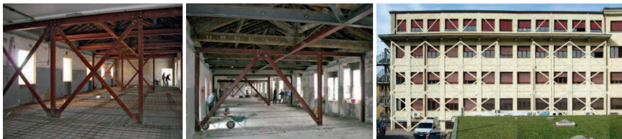
Figura 7 Esempi di inserimento di controventi in acciaio internamente o esternamente alla struttura (in alto).
