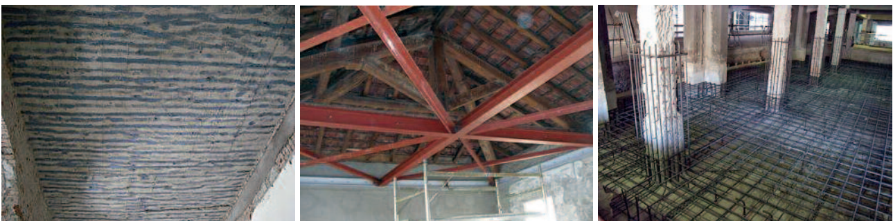
Figura 12 Esempi di rinforzo di un diaframma orizzontale: applicazione delle fibre di carbonio sul lato inferiore del solaio (sinistra), inserimento di controventi in acciaio (centro), getto di calcestruzzo al livello della fondazione (destra). Questi interventi costano circa 35 €/m 2 , più la sostituzione degli elementi non strutturali.
