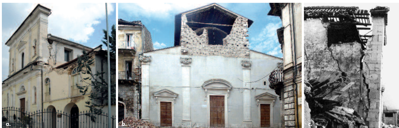
Figura 1 Esempi di meccanismi di danno tipici per le chiese: a) Santa Chiara a L'Aquila, frazione Paganica: ribaltamento della sommità della facciata; b) San Biagio d'Amiternum a L'Aquila, ribaltamento della sommità della facciata; c) Santa Maria del Fossale a Gemona: ribaltamento facciata.
