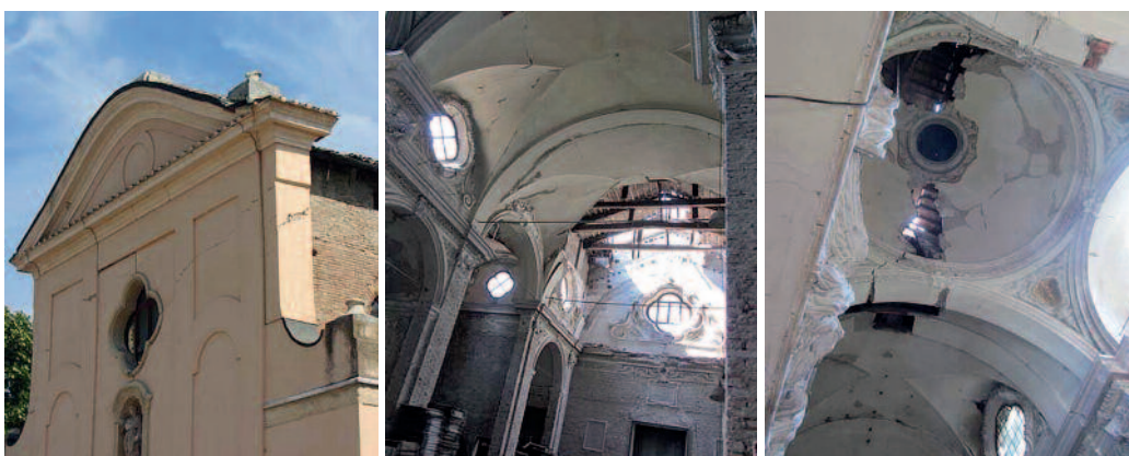
Figura 22 Chiesa di San Francesco a Finale Emilia: cinematico di collasso della sommità della facciata, vista esterna ed interna, e danno alle volte ( www.parrocchia-finaleemilia.it ).
