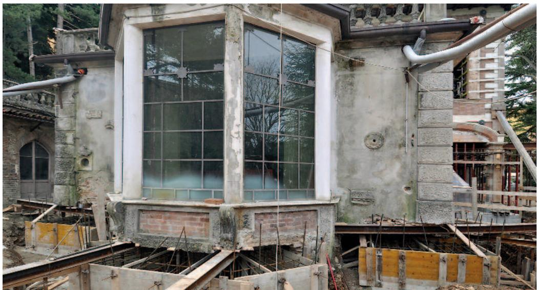
nerà il piano di calpestio al di sotto del quale rimarrà il vano tecnico per la manutenzione e controllo degli isolatori e rappresenta il piano rigido al di sopra il piano di scorrimento.
