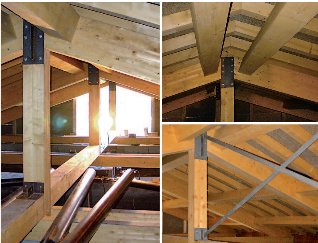
Figura 9 Dettagli della nuova copertura lignea.
