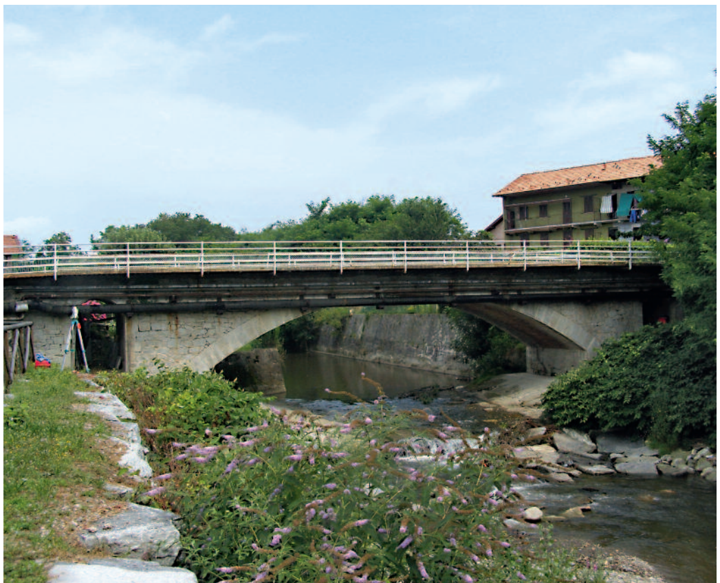
Figura 5 Vista di valle ravvicinata del Ponte San Marco esistente: si notano i servizi che in Progetto dovevano essere nascosti alla vista e la sostituenda passerella esistente ammalorata.
