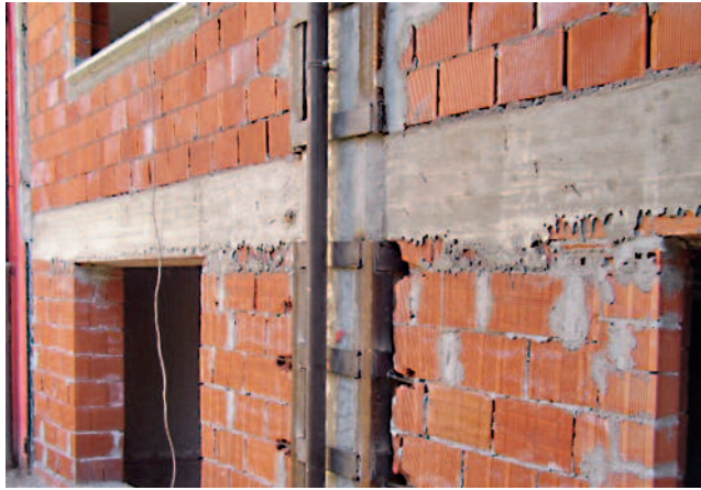
Figura 16 Dettaglio dei tamponamenti fra i pilastri rinforzati.
