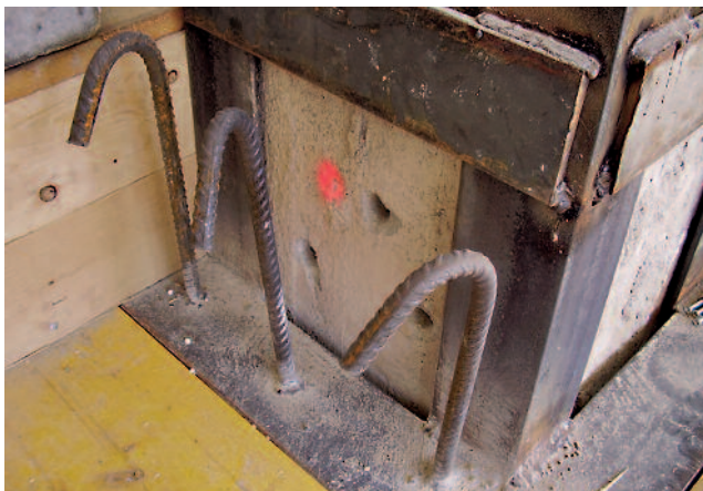
Figura 12 Calastrellatura di rinforzo dei pilastri esistenti.
