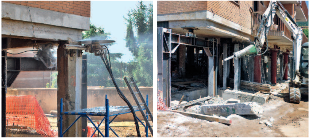
Figura 15 Taglio e demolizione pilastro in c.a. esistente.
