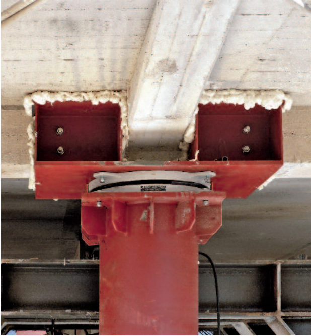
Isolatore a scorrimento a doppia superficie curva serie FIP-D
