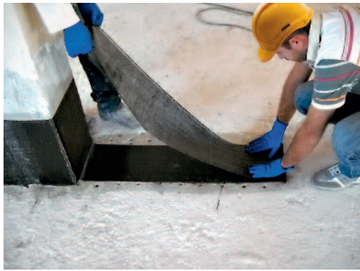
Figura 8 Posa in opera di rinforzo in FRP.
