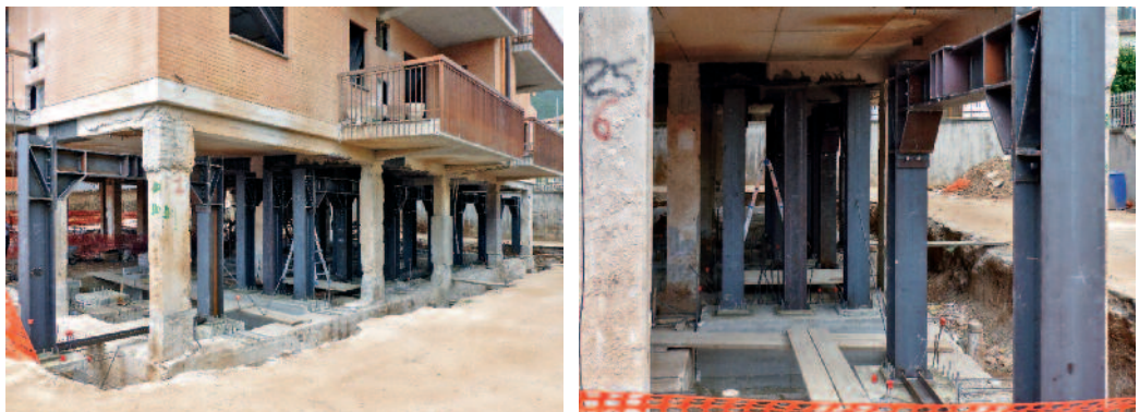
Figura 13 Posizionamento dei portali metallici con i martinetti idraulici in opera.
