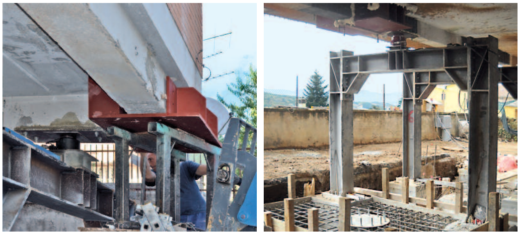
Figura 16 Inserimento pulvino in acciaio per attacco isolatore sismico.
