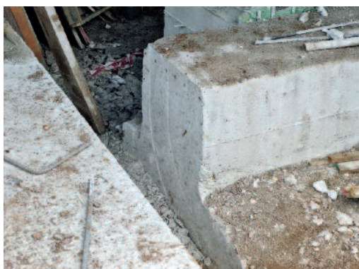
Figura 14 Taglio trave di fondazione esistente.
