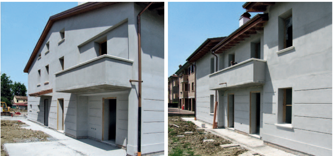
Figura 17 Viste dall'esterno dell'edificio in fase di realizzazione.
