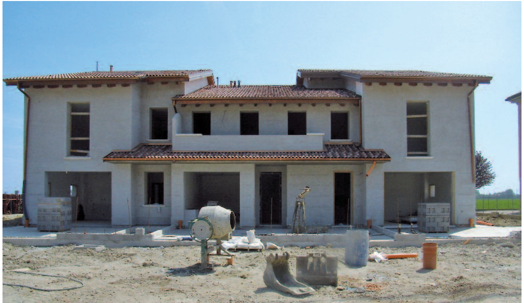
Figura 17 Viste dall'esterno dell'edificio in fase di realizzazione.
