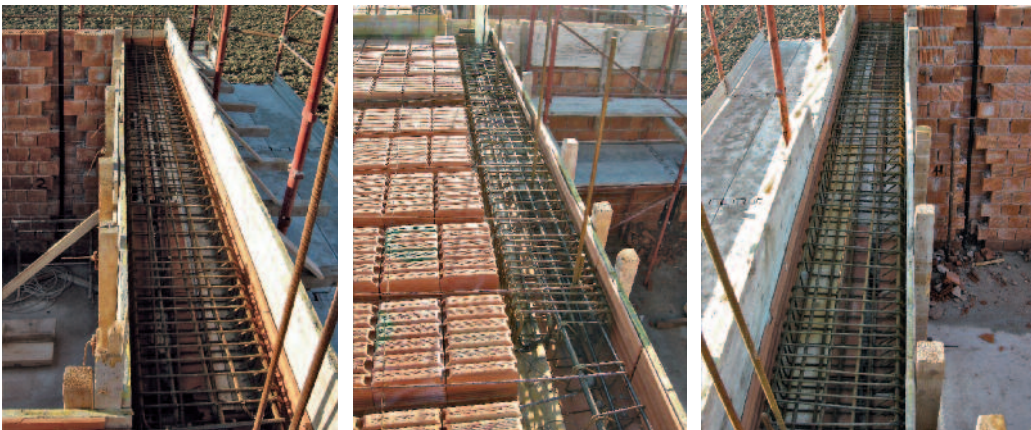
Figura 16 Fasi realizzative del solaio relativo al secondo piano.
