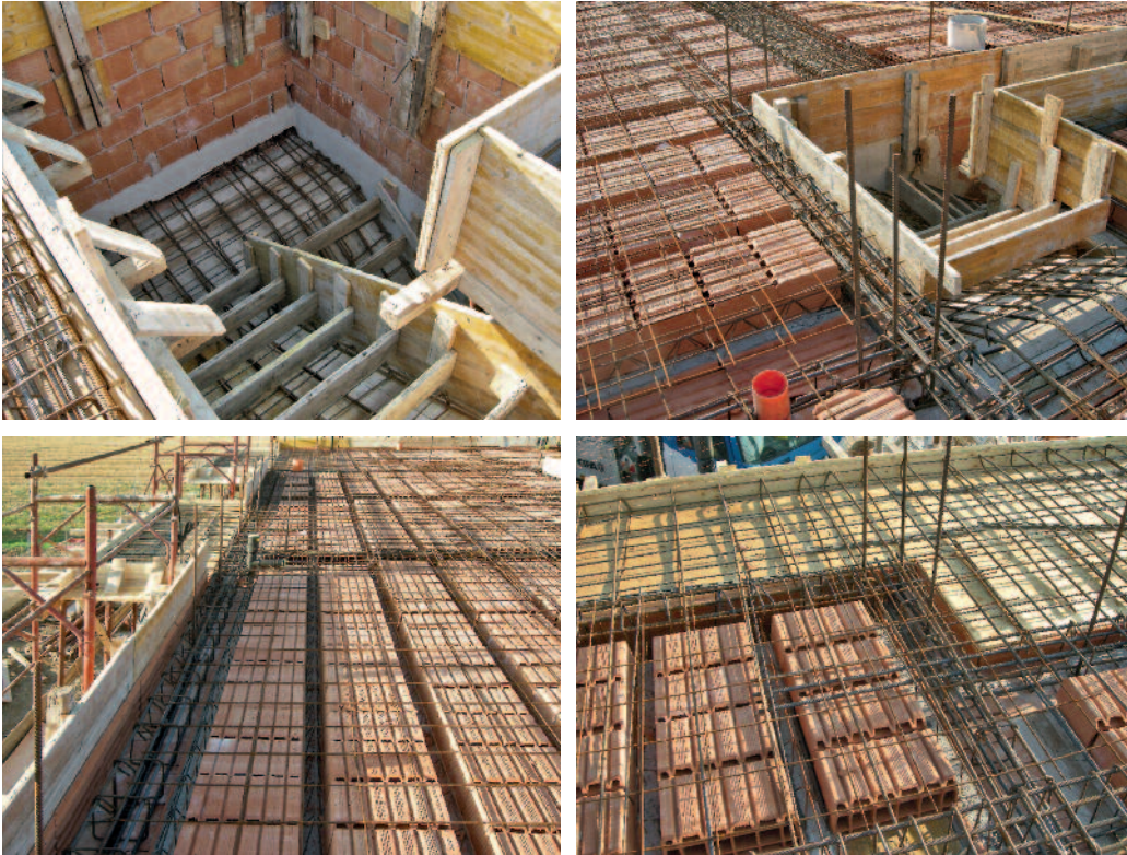
Figura 15 Fasi realizzative del solaio relativo al primo piano.
