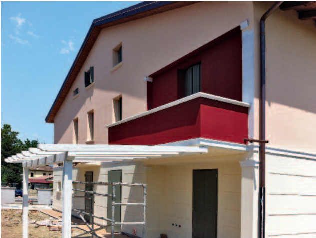
Figura 18 Viste dall'esterno dell'edificio a completamento dei lavori.
