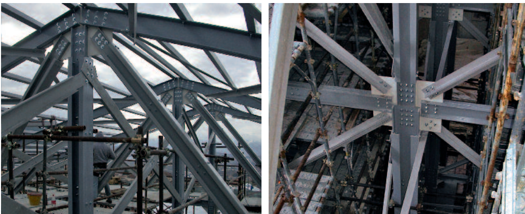
Figura 7 Dettagli dei nodi, strutture 1 e 2.
