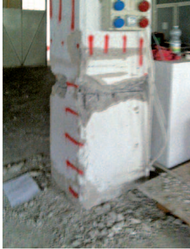
Figura 3 Identificazione, mediante pacometro, e tracciamento della posizione delle armature nei pilastri (a sinistra).
