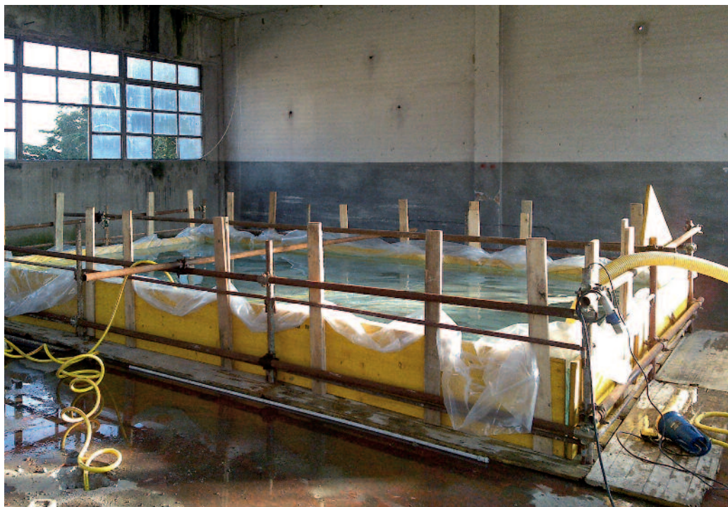
Figura 23 Predisposizione della vasca di carico sul solaio.
