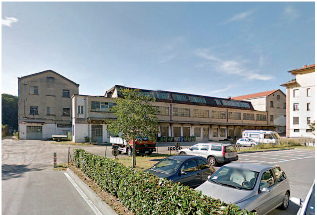
Figura 2 a) Vista dall'esterno dello stabile oggetto dello studio; b) il corpo di fabbrica centrale monopiano con copertura a shed e uno dei copri laterali a due piani fuori terra e tetto a capanna.
